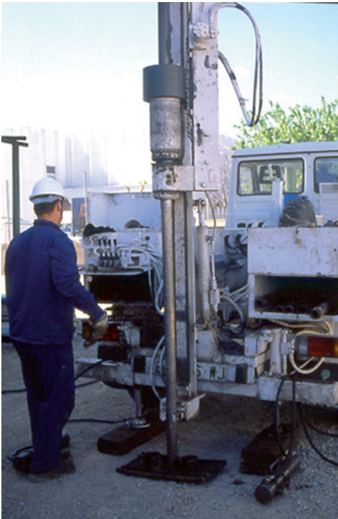
Fig. 86 86 Penetròmetre dinàmic acoblat a camió de geotècnia.
