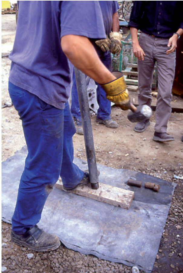
Fig. 184 Extracció de la mostra continua del sondatge a cops de mall 1.
