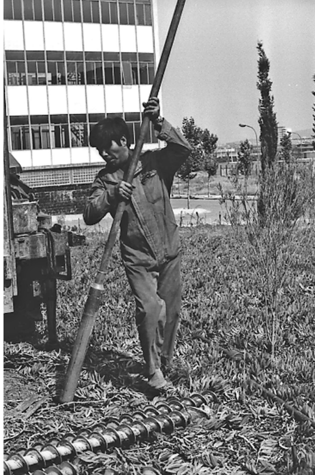
Fig. 180 Extracció del tub de son- datge amb el llevamostres inalterades (ETSAB, 1979).
