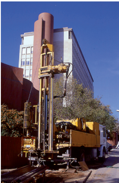
Fig. 163 Sondatge per rotació al carrer d'Adolf Florensa, Barcelona.
