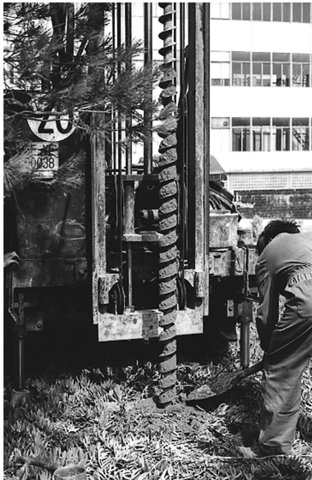
Fig. 190 El sondatge amb barrina helicoida proporciona una mostra contínua molt alterada (ETSAB, 1979).
