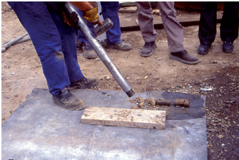
Fig. 185 Extracció de la mostra continua del sondatge a cops de mall 2.
