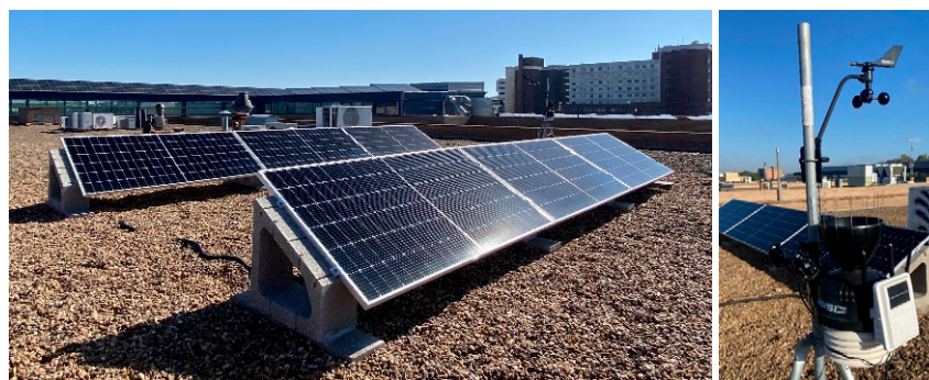
Figura 3: Instalación PV de 4,08 kW ubicada en la cubierta de una vivienda unifamiliar en Castañar de Ibor, provincia de Cáceres, Extremadura.
