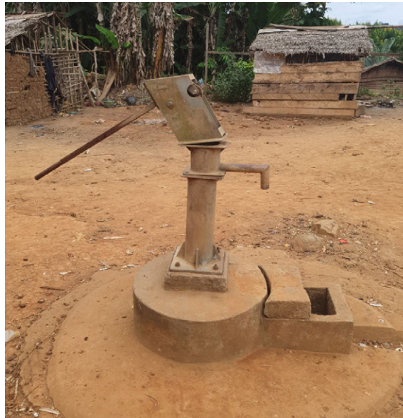
Figura 2: Bomba manual Indian Markt II (no operativa). Mveng, Sur de Camerún.
