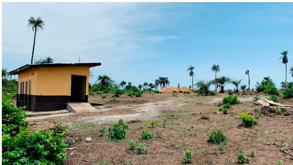
Figura 6: Edificio de letrinas con fosa séptica finalizado, en las zonas comunes reservadas. Al fondo a la derecha el pozo.
