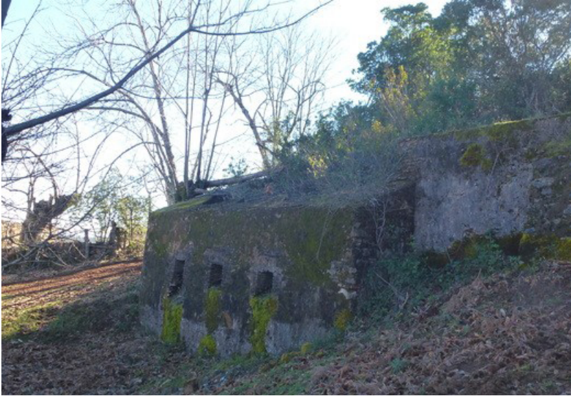
Figura 17. Tolva de la mina de San José (Castaño del Robledo).
