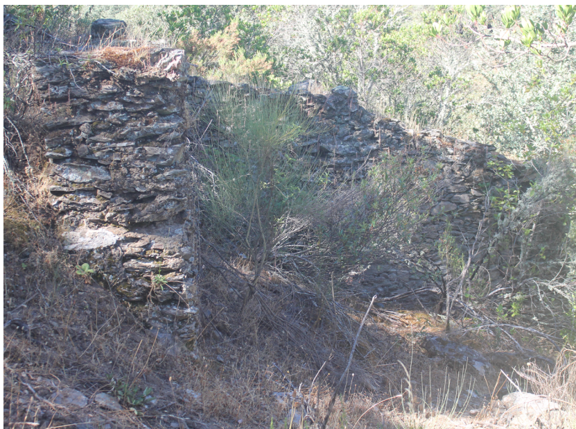
Figura 11. Casa de la mina de Risco de la Hoya (Aracena).
