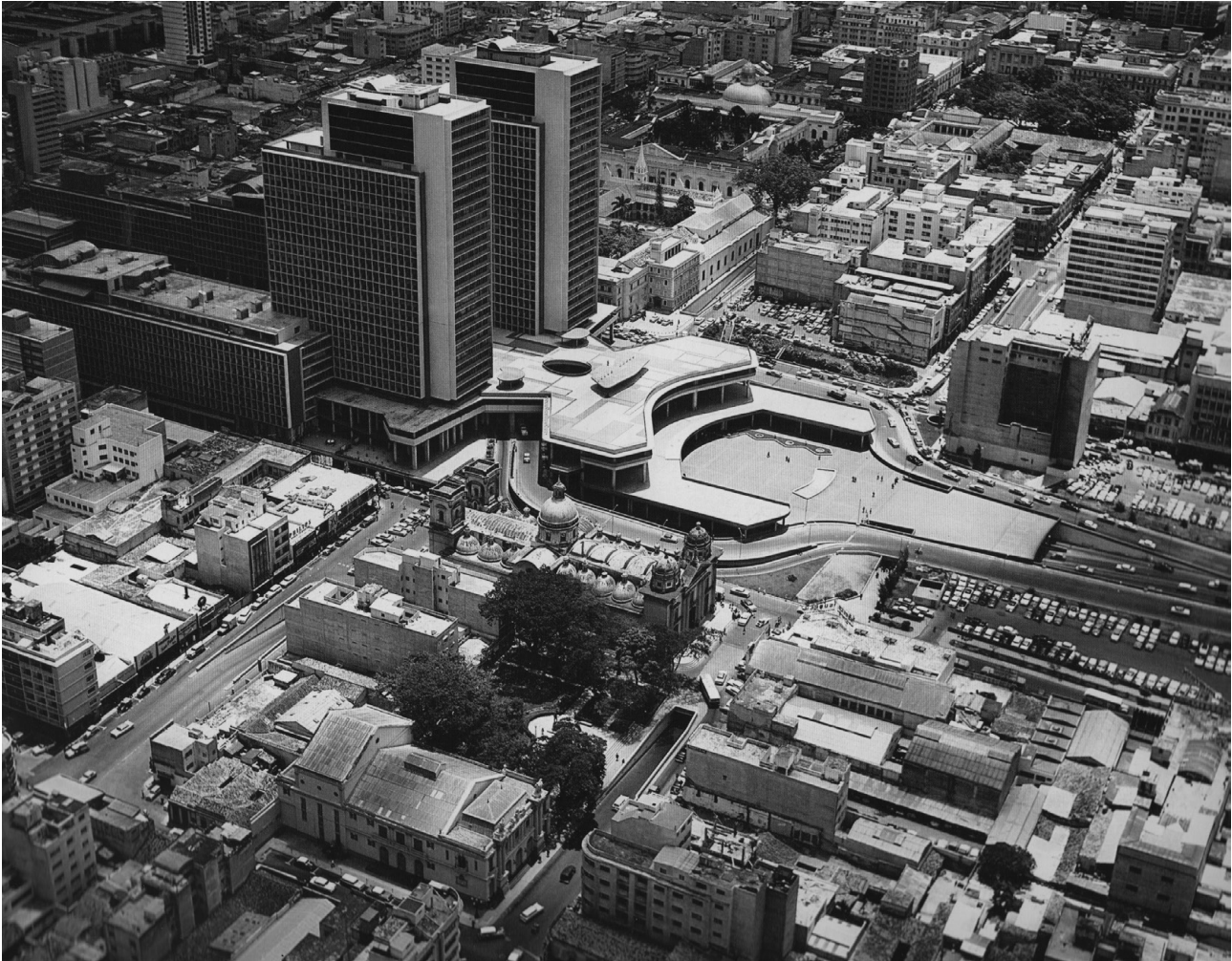
Fig.3. CA17 - Centro Simón Bolívar, Caracas, 1948-54. Arquitecto Cipriano Domínguez. Fotógrafo Myron Dmytrejchuk, ca. 1956, Archivo Fotografía Urbana.
