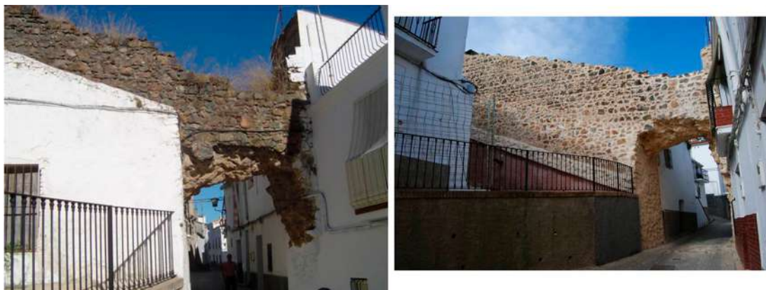
Fig. 88. Vista del antes y después de la zona intervenida (Fotos N. Medina).
