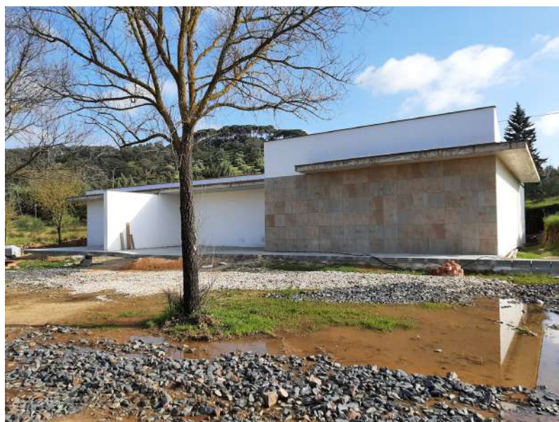
Fig. 119. Vista del nuevo edificio en construcción (Foto N. Medina).
