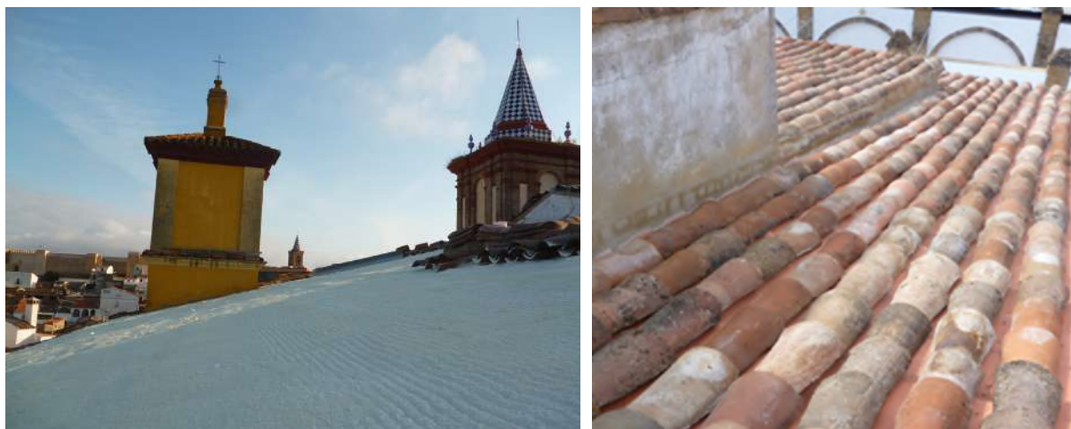
Fig. 78 y 79. Proceso de reforma de las cubiertas (Fotos N. Medina).
