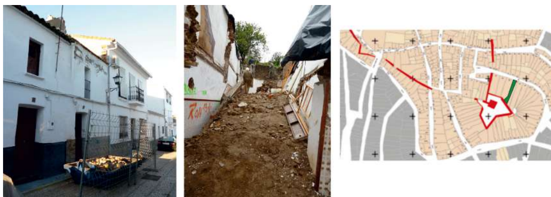
Fig. 104. Ubicación del inmueble en relación a la torre y trabajos de derribo (Fotos N. Medina).
