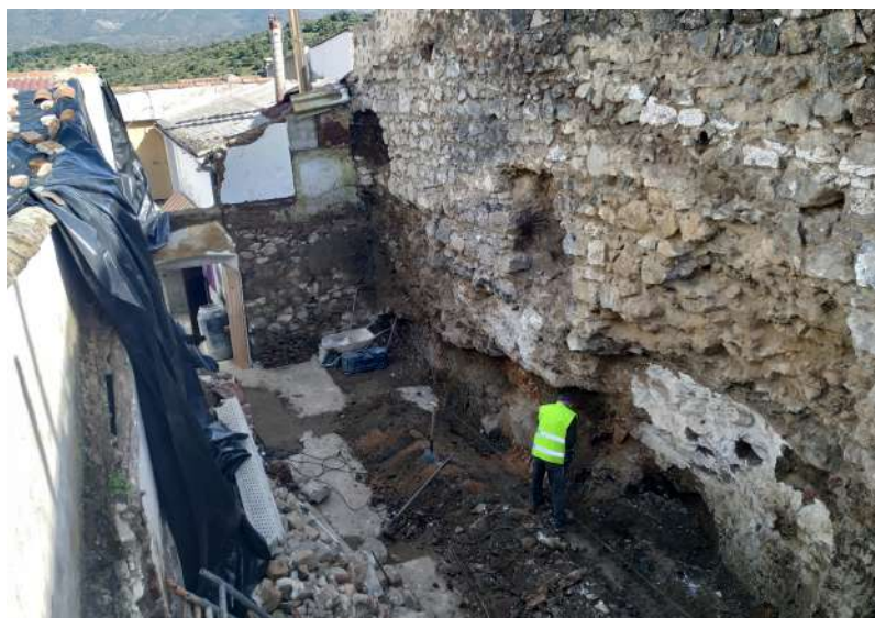
Fig. 103. Vista de la evolución de las obras.
