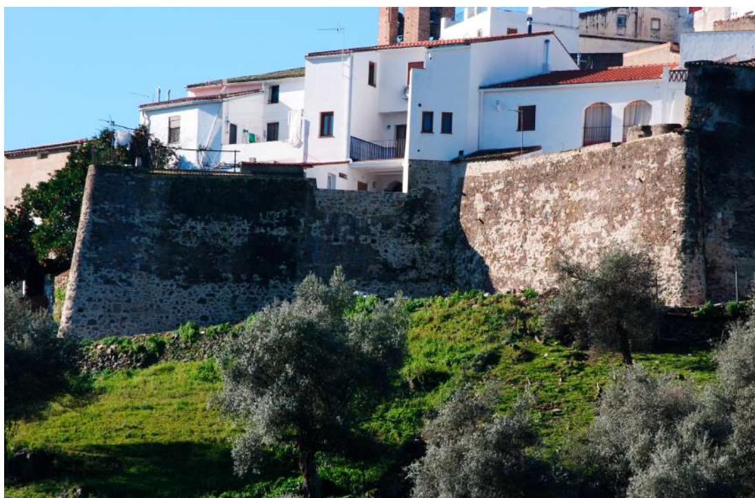
Fig. 95 y 96. Vista del proceso de las obras (Fotos N. Medina).
