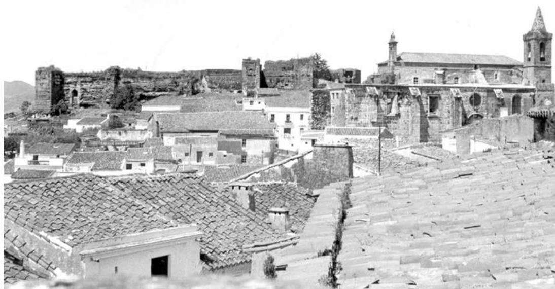
Fig. 17. Vista de la iglesia con cubierta y castillo en ruinas, años 70 (Foto J. Alcaide).
