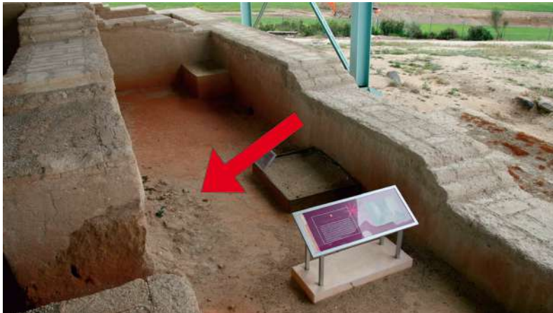
Fig. 152. Fotografía de la web https://campanario.es/turismo/que-visitari-yacimiento-prototestorico-de-la-mata/ donde se observa el deterioro de las estructuras.
