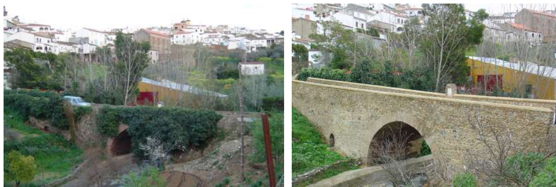
Fig. 27 y 28. Vistas antes y después de la intervención (Fotos N. Medina).
