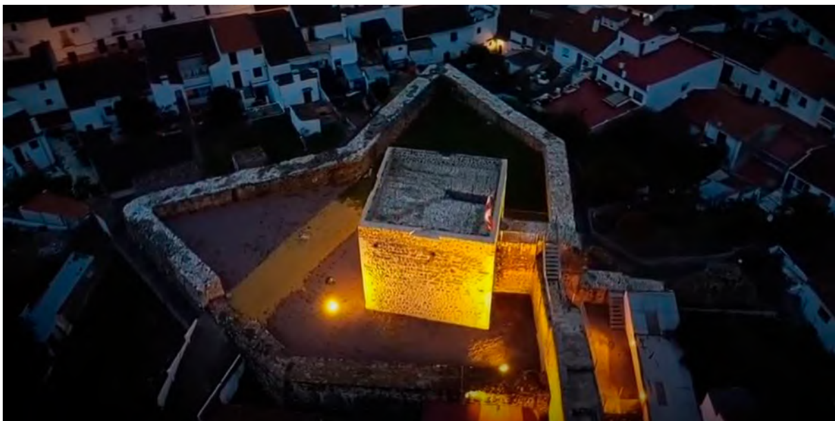
Fig. 108. Vista actual de la Torre de San Ginés (Foto Marcos Villar).
