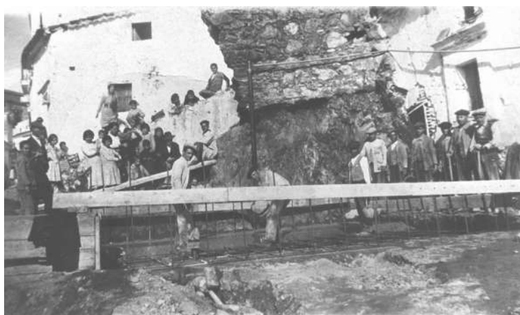
Fig. 9. Construcción de la Fuente de los 9 caños en 1932 junto a la desaparecida Puerta de la Fuente o Trinidad. (Foto José Alcaide).
