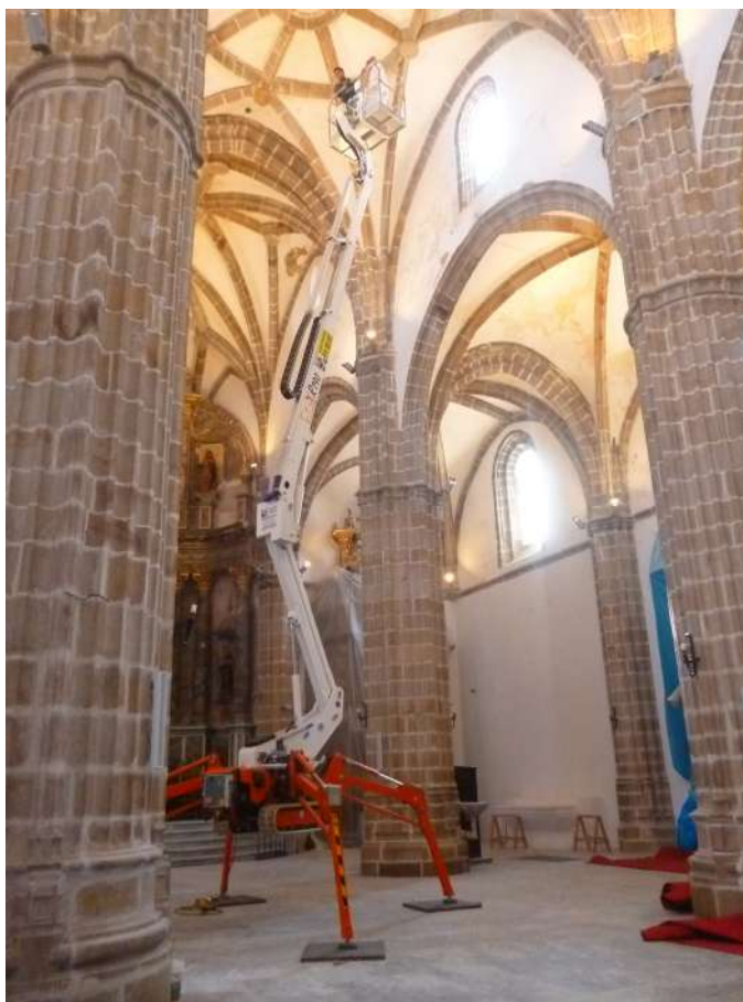
Fig. 109. Vista de la maquinaria para los trabajos de pintura (Fotos N. Medina).
