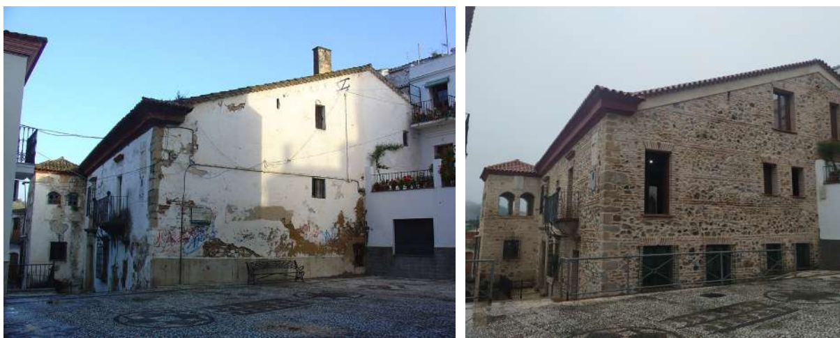
Fig. 110 y 111. Antes y después de las obras en la Casa Palacio (Foto N. Medina)
