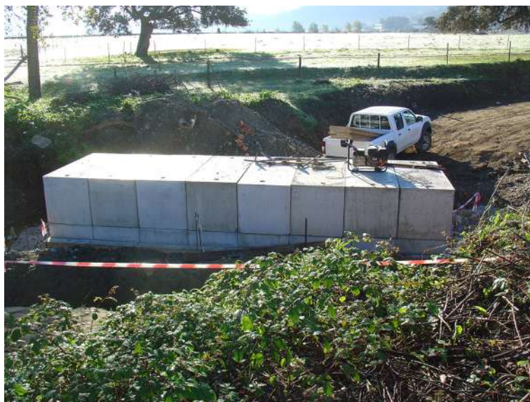
Fig. 32 Vista de la construcción del puente (Fotos N. Medina).
