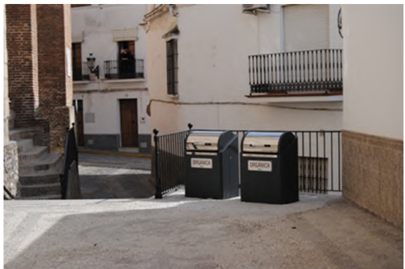
Fig. 115. Vista de los contenedores semisoterrados (Foto N. Medina).
