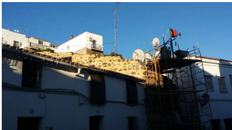
Fig. 94. Detalle del escalonamiento del adarve (Foto N. Medina).
