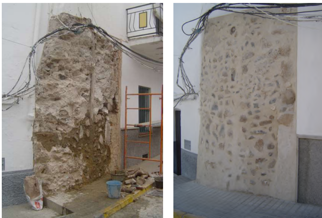
Fig. 92 y 93. Vista de la primera intervención en Calle Puerta de Sevilla (Fotos N. Medina).
