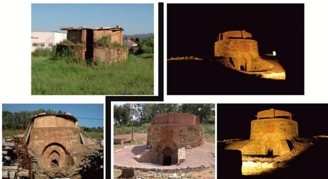
Fig. 118. Restauración del horno de ladrillos (Fotos N. Medina).
