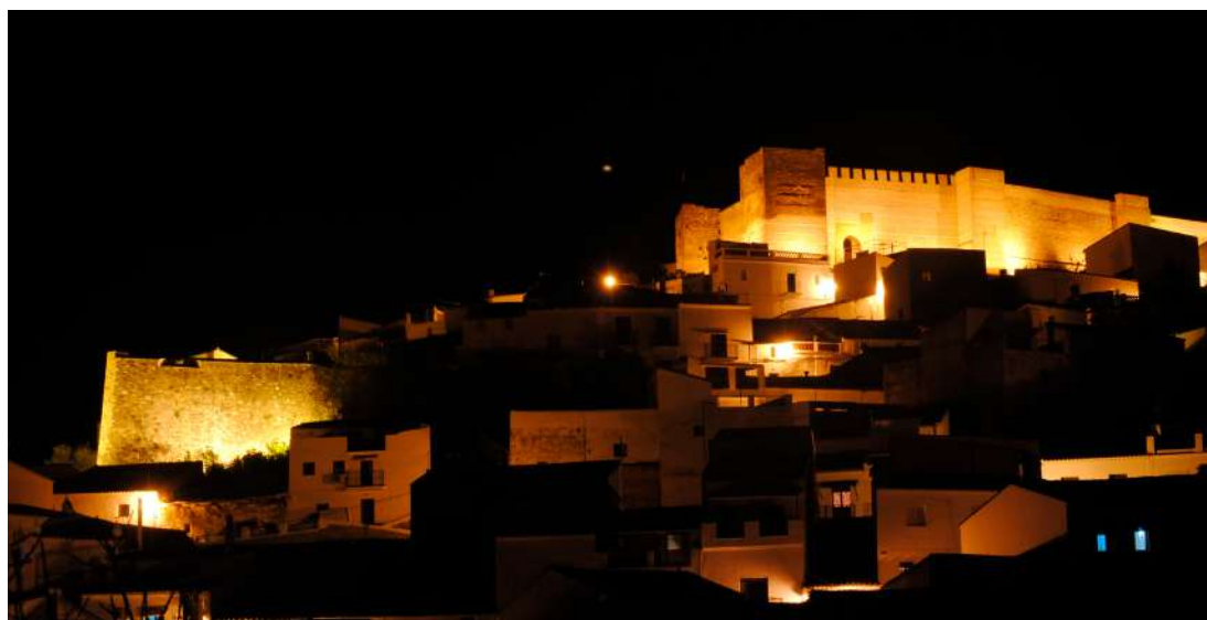
Fig. 97 y 98. Antes y después de las obras (Foto N. Medina).
