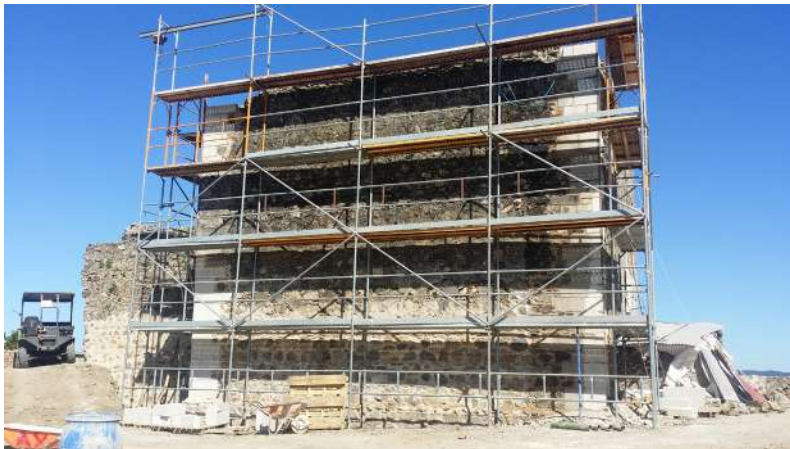
Fig. 107. Trabajos de restauración y recuperación de la Torre (Foto N. Medina).
