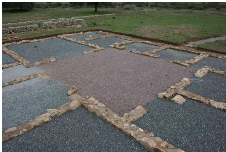
Fig. 47. Vista del proceso de adecuación de la Casa Norte (Foto N. Medina).
