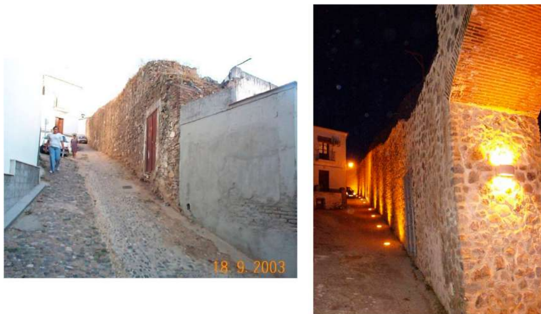
Fig. 36. Vista de la muralla antes y después.
