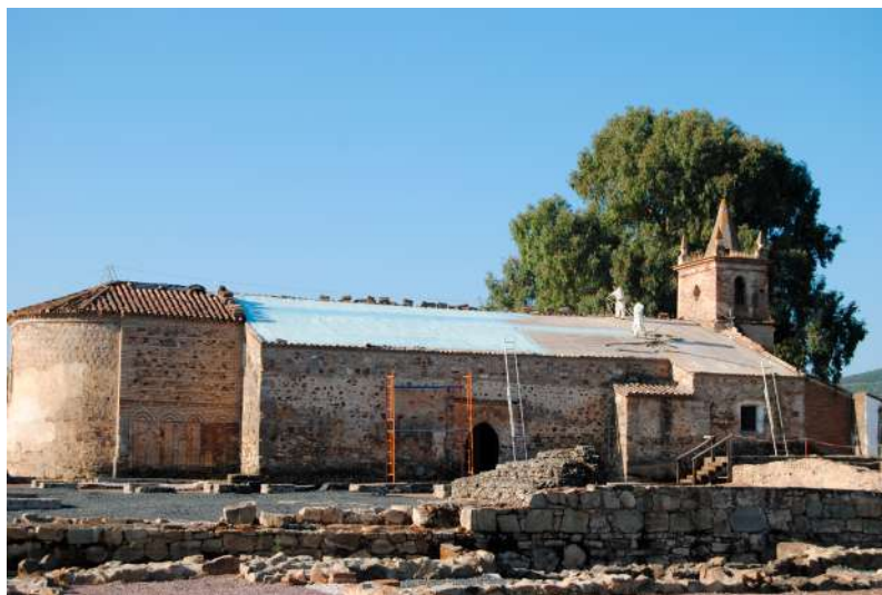
Fig. 65. Vista de los trabajos de rehabilitación e impermeabilización de la cubierta (Foto N. Medina).
