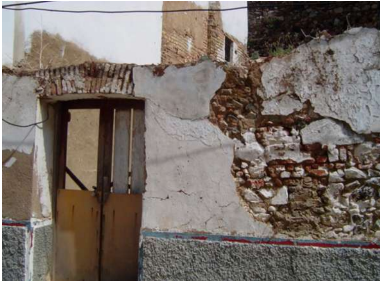
Fig. 41. Vista fachadas de inmuebles adquiridos para su derribo (Fotos N. Medina).
