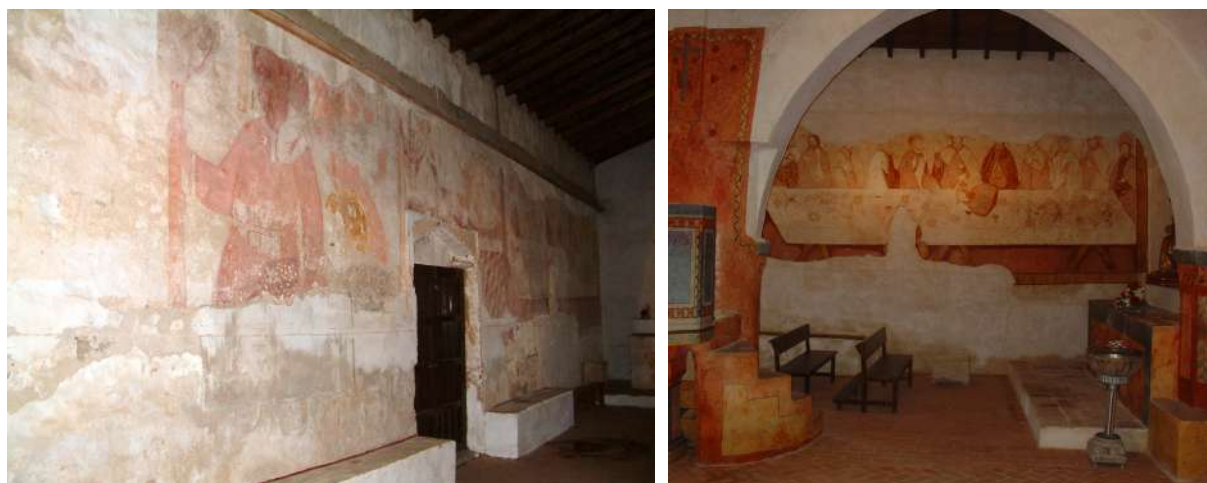
Fig. 63 y 64. Detalle del muro Norte antes y después de la intervención (Fotos N. Medina).
