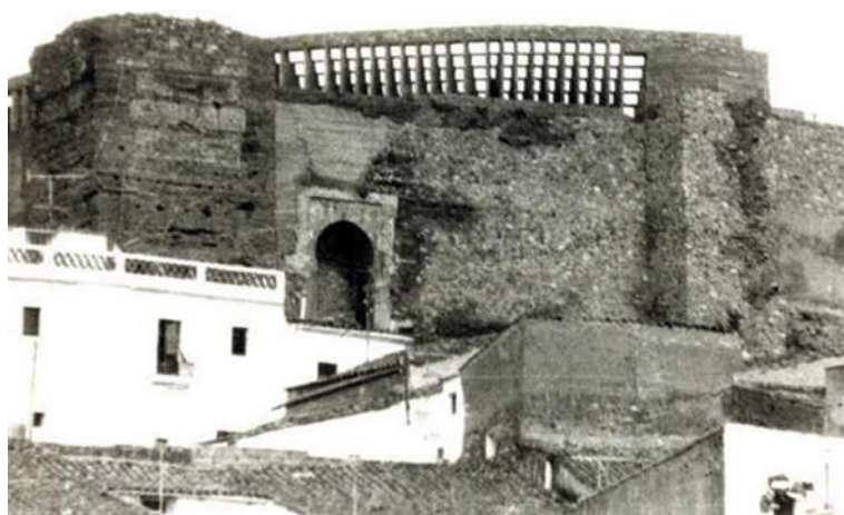
Fig. 7. Estado ruinoso del castillo y del recrecido de graderíos (Foto Alcaide).
