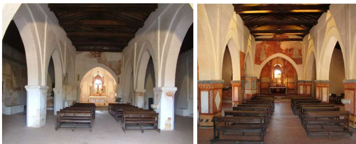
Fig. 61 y 62. Estado de la ermita antes y después de la intervención (Fotos N. Medina).
