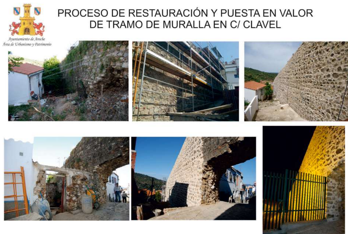
Fig. 91. Proceso de recuperación del lienzo de Calle Clavel (Fotos N. Medina).
