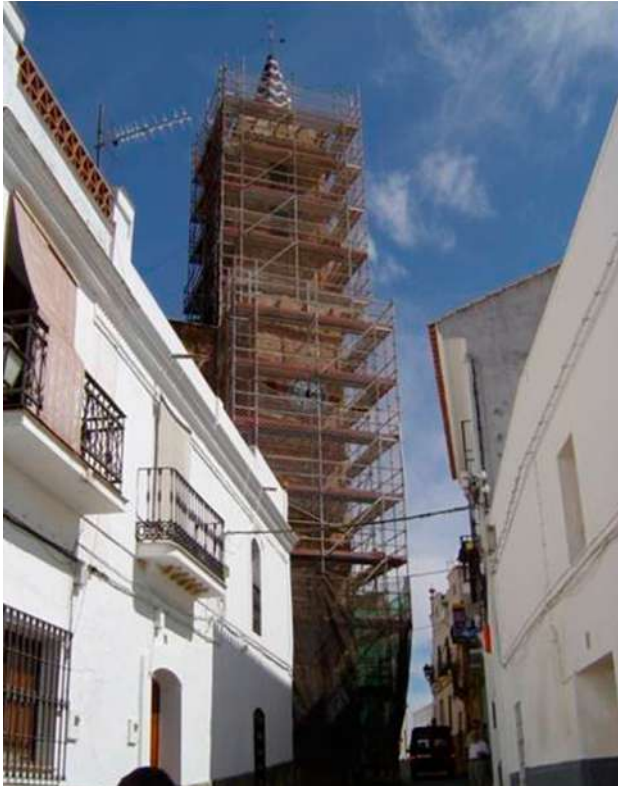
Fig. 40. Vistas del proceso de obras, interior y exterior (Fotos N. Medina).
