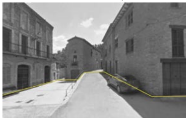
TRAMO 2 Rehabilitación - zona peatonal
