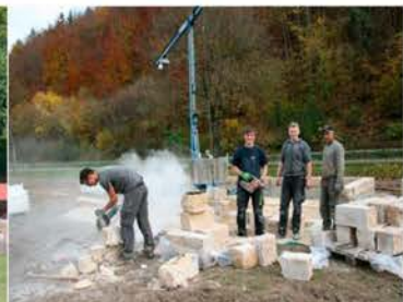
La instalación de juegos y ocio Dobel-SpaTZ ha estado en construcción desde septiembre de 2017. Esto también incluye varias asignaciones de trabajo por parte de voluntarios.
