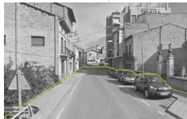
TRAMO 3 Viaro - tramo peatonal
