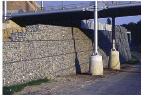
Fig. Gabions de contenció en parcs i vials
