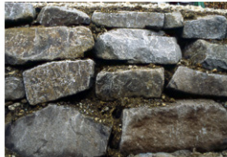
Mur de pedra en sec. Detall
