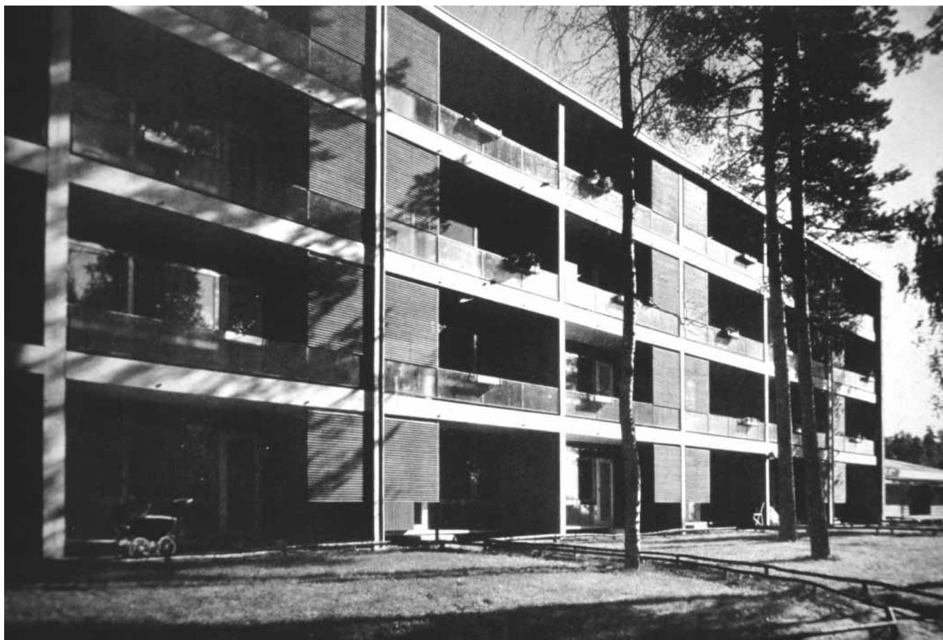
33 Viljo Revell, Viviendas en Tapiola . Helsinki (Finlandia). 1952-1959
