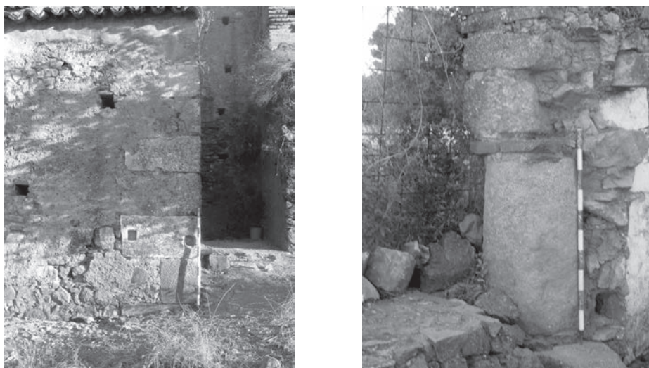
Figura 5. Sillares y fustes romanos aprovechados en el cuerpo de la Ermita de la Virgen de Cala.
