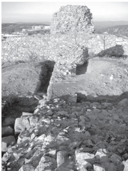
Figura 6. Muralla Diafragma, entre la Torre Mayor y la Torre 3 del castillo de Aracena que delimita el Alcázar del patio de armas.
