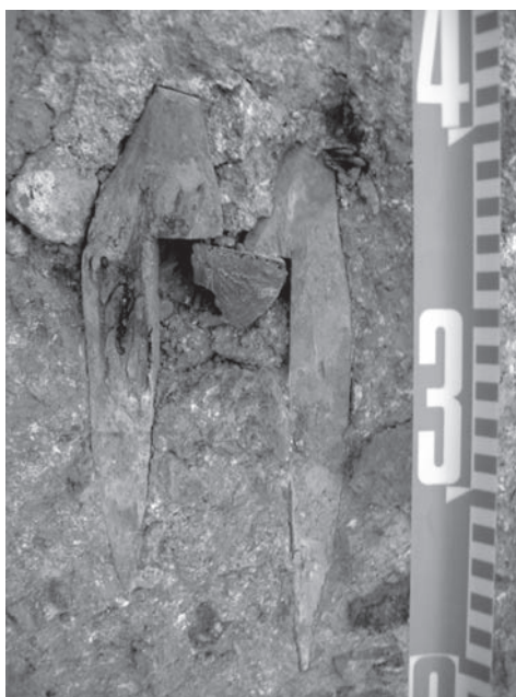
Figura 2. Detalle de piezas de madera empleadas en el encofrado del tapial del castillo de Aroche, insertadas en la fábrica.
