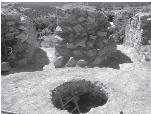
Figura 11. Interior de la Torre A del castillo de Cala con subestructura y vanos orientados hacia el castillo de Real de la Jara.
