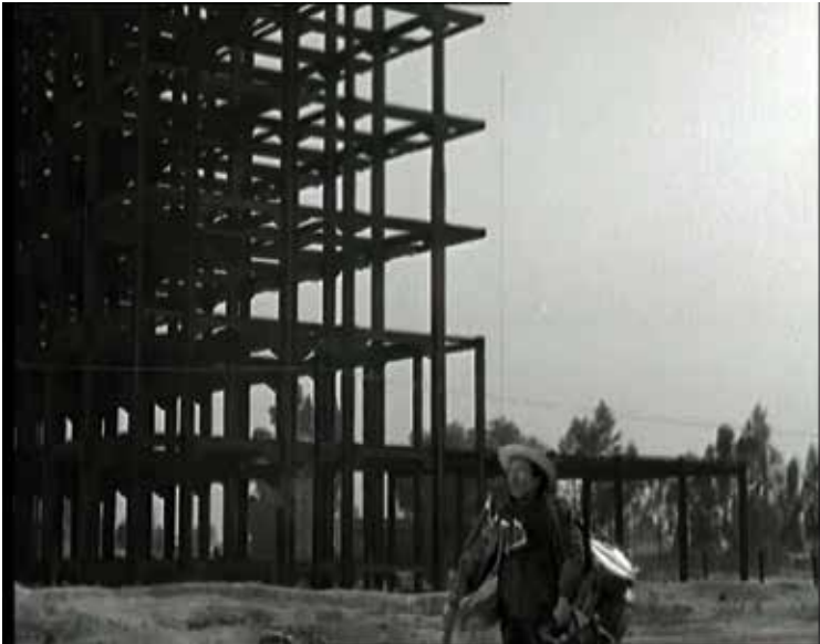
8. Las estructuras metálicas como fondo de las andanzas del ciego de Los olvidados. Luis Buñuel. 1950
