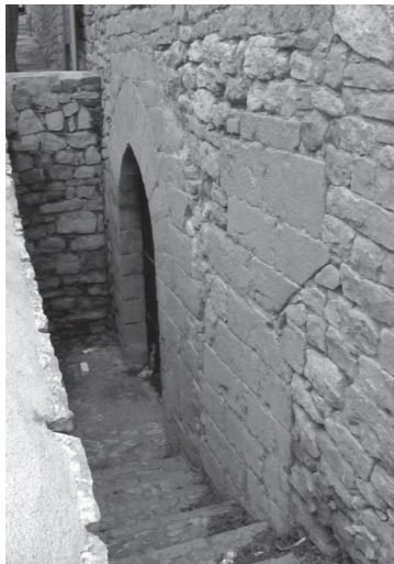
Fig. 19. Restos de la puerta desaparecida.
