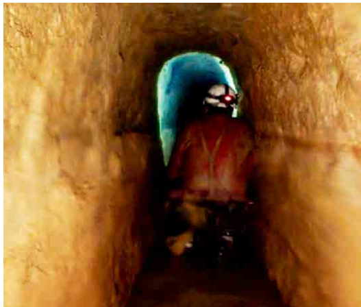
Figura 39. Tramo de la galería Puerto de Brenes (Millán Naranjo, 2015).
