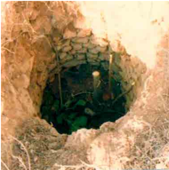
Figura 65. Spiramina del acueducto de Thapsus (Younes, 2015).
