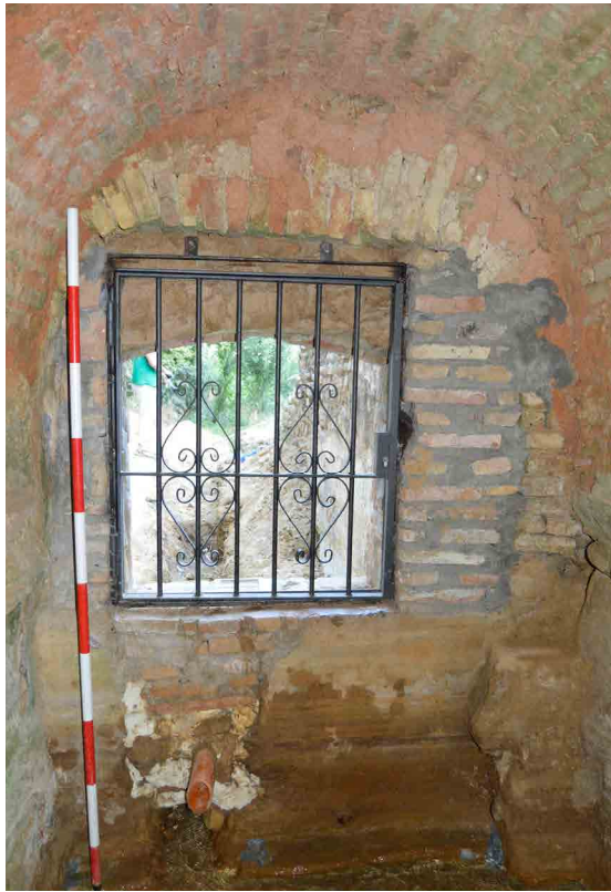
Figura 38. Vano original proyectado en el paramento occidental tras su reconstrucción.
