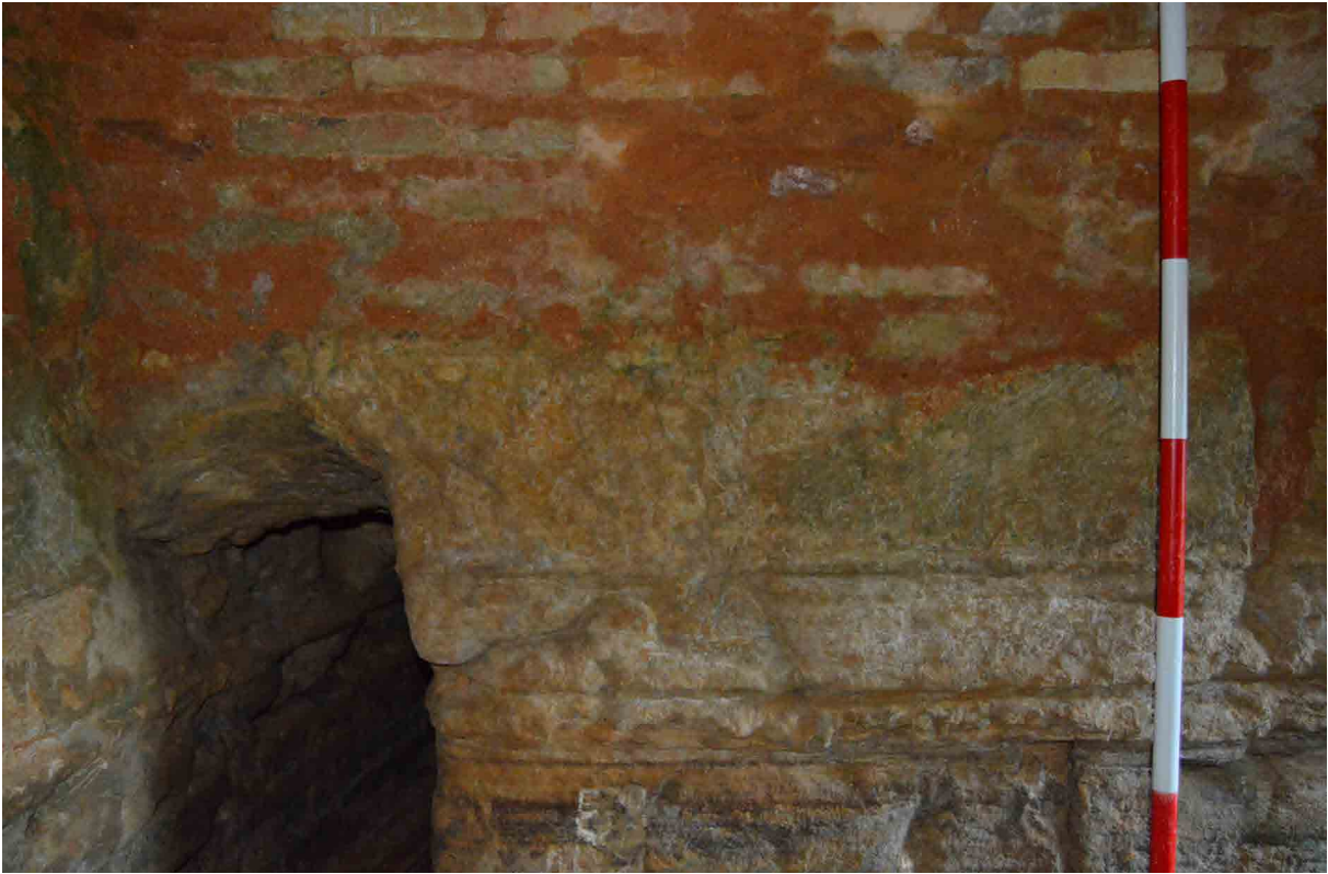
Figura 27. Sillar oriental de la segunda tongada labrado para dar cabida al acceso de la galería sur.
