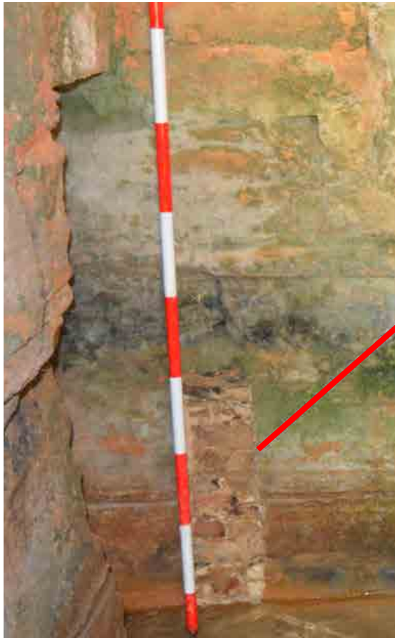
Figura 17. Foto detalle de las sucesivas hileras de ladrillos que conformaron la obra primigenia en el paramento oriental.
