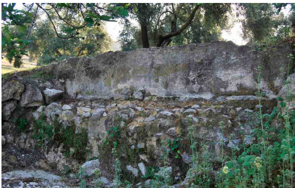
Figura 15. Acueducto romano de Ucubi, trazado sobre substructio (Emilio López, 2012).
