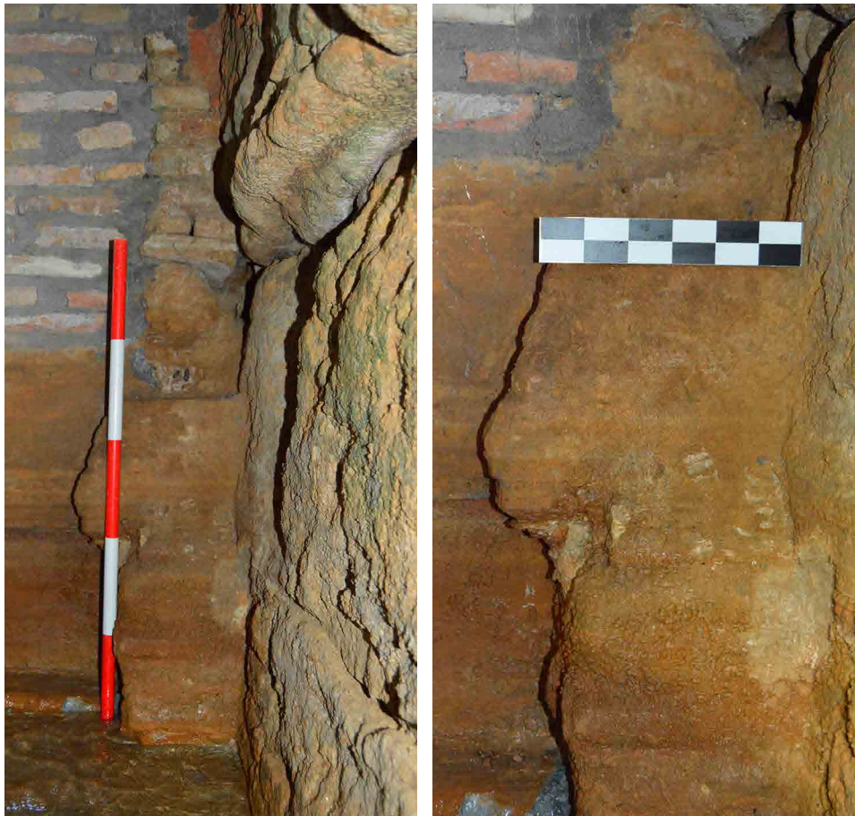
Figura 20. Restos del entalle de la obra primigenia de los muros septentrional y occidental.
