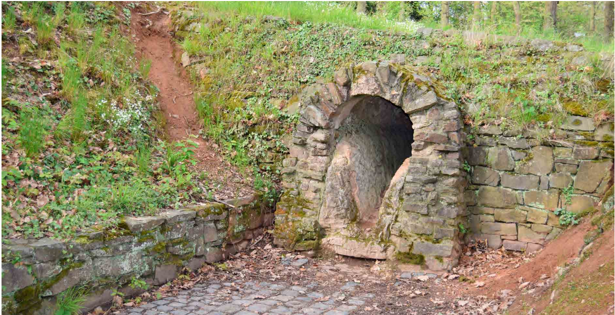
Figura 74. Galería del acueducto romano de Colonia a su paso por Kreuzweingarten donde se puede apreciar también las concreciones calcáreas adosadas al specus .
