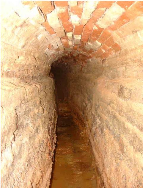
Figura 3. Galería principal del acueducto, obsérvese la fábrica en ladrillos.
