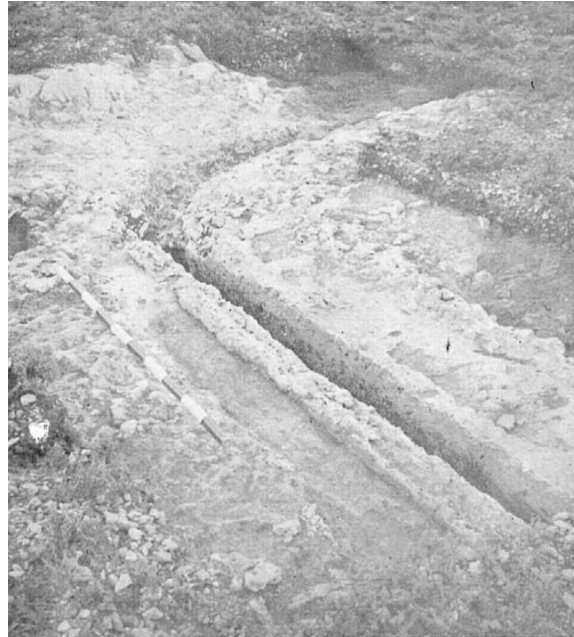
Figura 63. Tramo de galería en zanja del acueducto de Segobriga (Almagro Basch, 1978).
