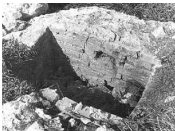
Figura 33. Spiramina de la segunda conducción (Canto, 1979).
