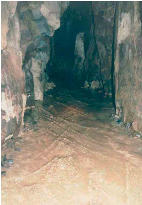
Figura 6. Galería captación de Vallehermoso (Empresa Municipal de Aguas de Córdoba).
