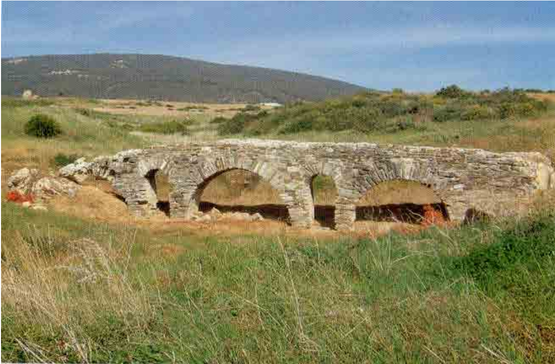
Figura 22. Acueducto de Punta Paloma (Lagóstena Barrios, 2009).
