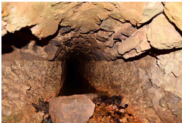
Figura 71. Interior de la galería de captación de Grüner Pütz.
