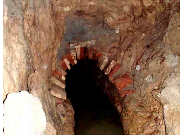
Figura 43. Tramo de la galería Puerto de Brenes con revestimiento de ladrillo (Millán Naranjo, 2015).
