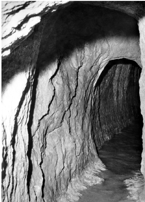
Figura 60. Galería de captación acueducto de Segobriga (Almagro Basch, 1976).
