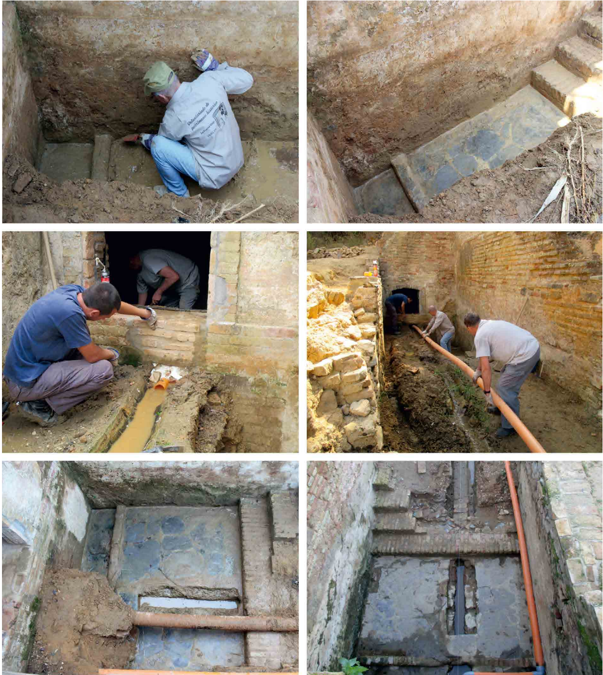
Figura 5. Tareas de desescombro en la fuente.
