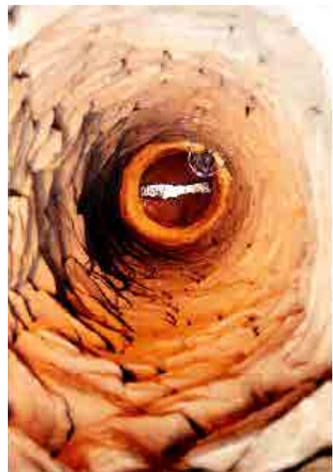
Figura 76. Spiramen del acueducto romano de Raschpëtzer (Kayser y Waringo, 2003).
