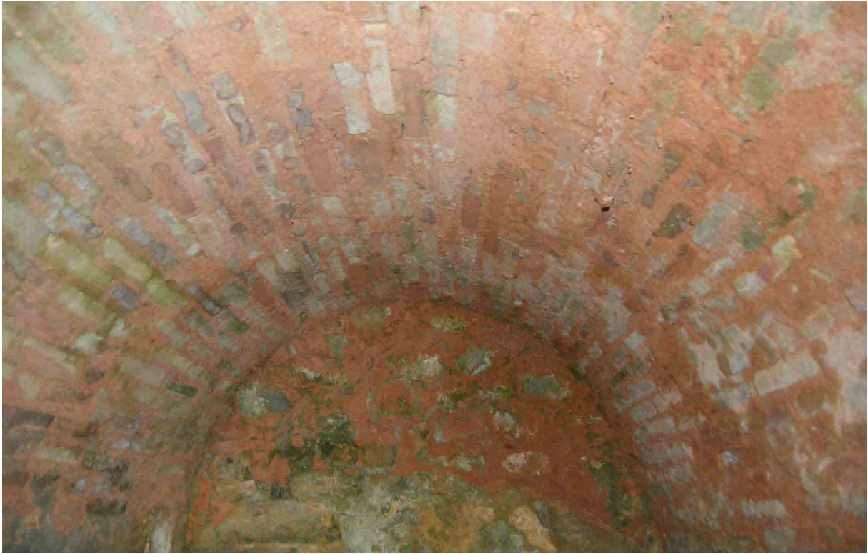
Figura 35. Bóveda de medio cañón que articula el sistema de cubierta del depósito.
