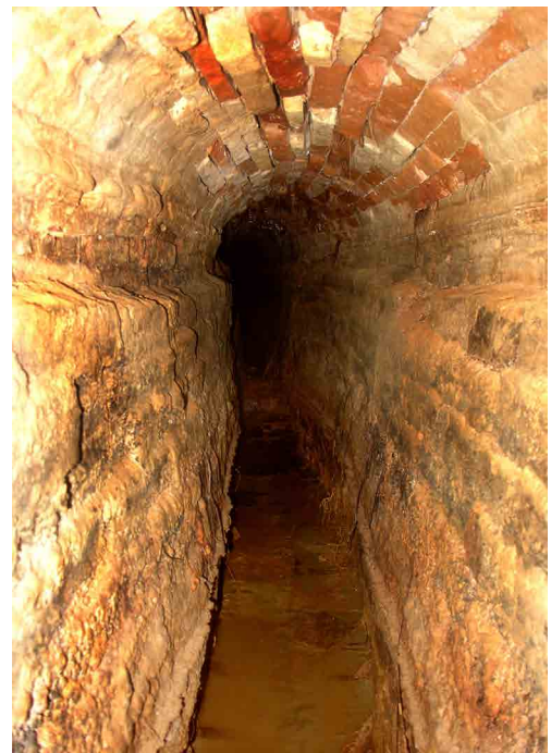
Figura 9. Galerías sur, obsérvese la fábrica en opus latericium .
