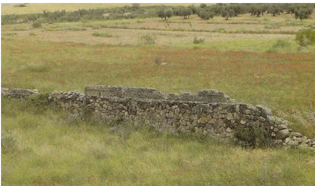
Figura 58. Acueducto La Alcantarilla, tramo sobre subestructo (Arenillas y Barahona, 2008).
