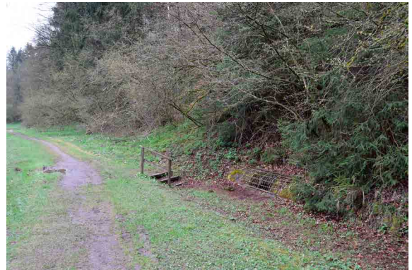
Figura 70. Galería de captación siguiendo el perfil de la montaña.
