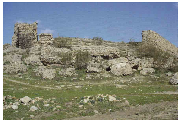
Figura 56. Tramo del interior de la galería (Macías y Puche, 2004).
