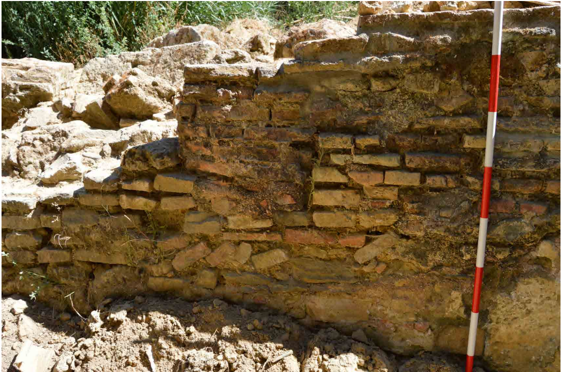
Figura 60. Desarrollo final del paramento septentrional donde son apreciables las últimas remodelaciones llevadas a cabo en su extremo occidental tras la desaparición de la caseta.
