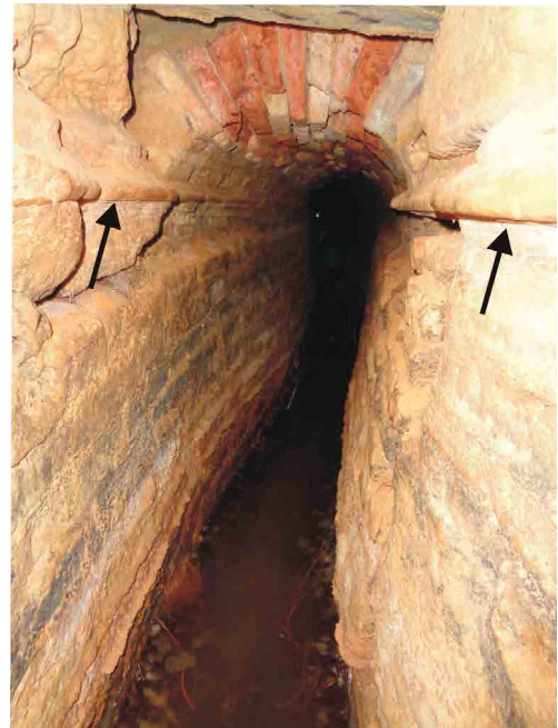
Figura 12. Fotografía de las concreciones calcáreas horizontales con forma de molduras que se observan en las paredes del depósito de Fuente Vieja y las galerías adyacentes. Estas estructuras se forman por la precipitación de carbonato cálcico durante largos periodos de tiempo, probablemente por el abandono y la falta de mantenimiento de las galerías.
