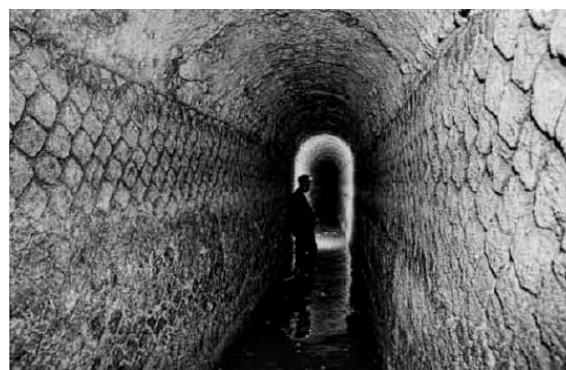
Figura 88. Tramo de galería (Santucci y Presci, 2013).
