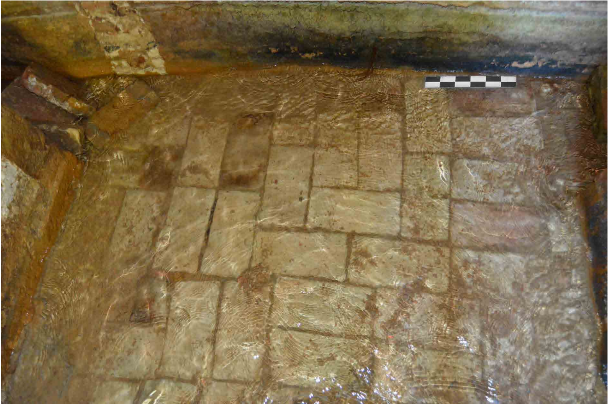
Figura 34. Pavimentación actual de Fuente Vieja.
