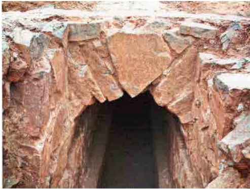
Figura 46. Galería del acueducto de Los Milagros (Pizzo, 2015).
