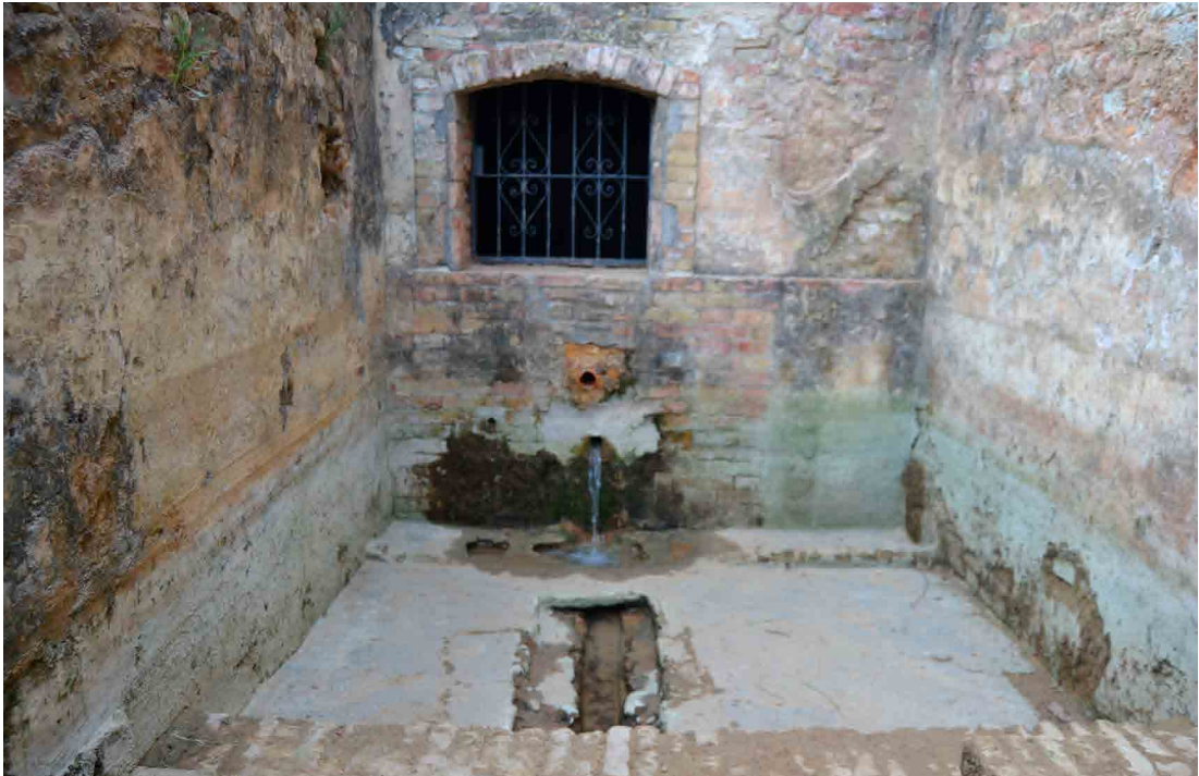
Figura 59. Pavimento y atarjea empleada en la construcción de Fuente Vieja para facilitar el acceso de la población hasta los pies del depósito.
