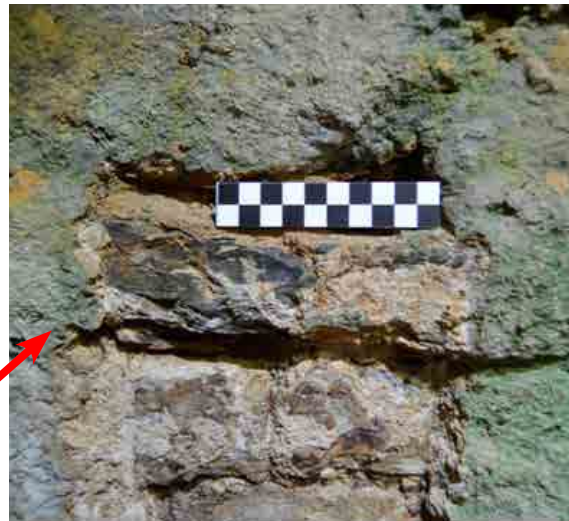
Figura 17. Foto detalle de las sucesivas hileras de ladrillos que conformaron la obra primigenia en el paramento oriental.
