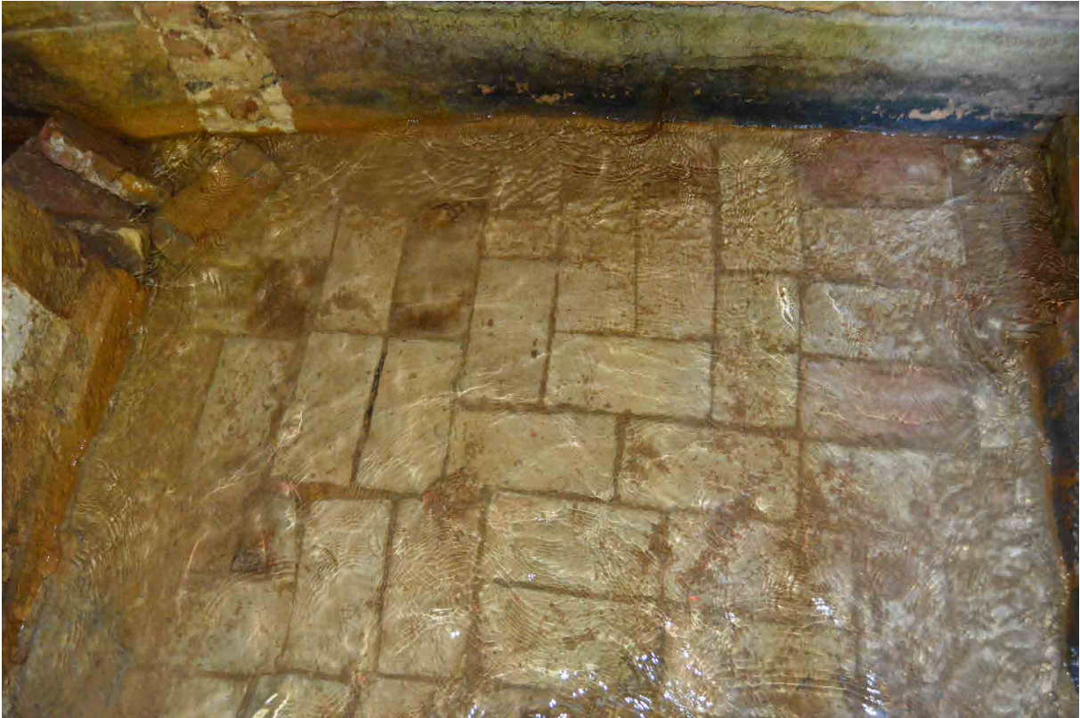
Figura 13. Pavimento correspondiente a una obra de mantenimiento en 1849.
