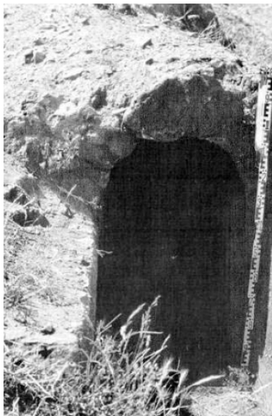
Figura 29. Galería del acueducto primitivo (Canto, 1979).
