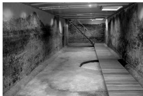
Figura 40. Spiramina de acceso a la galería Puerto de Brenes (Millán Naranjo, 2015).
