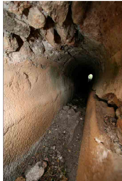
Figura 20. Galería del acueducto de Gades a su paso por Fuente Ymbro (Lagóstena, 2009).
