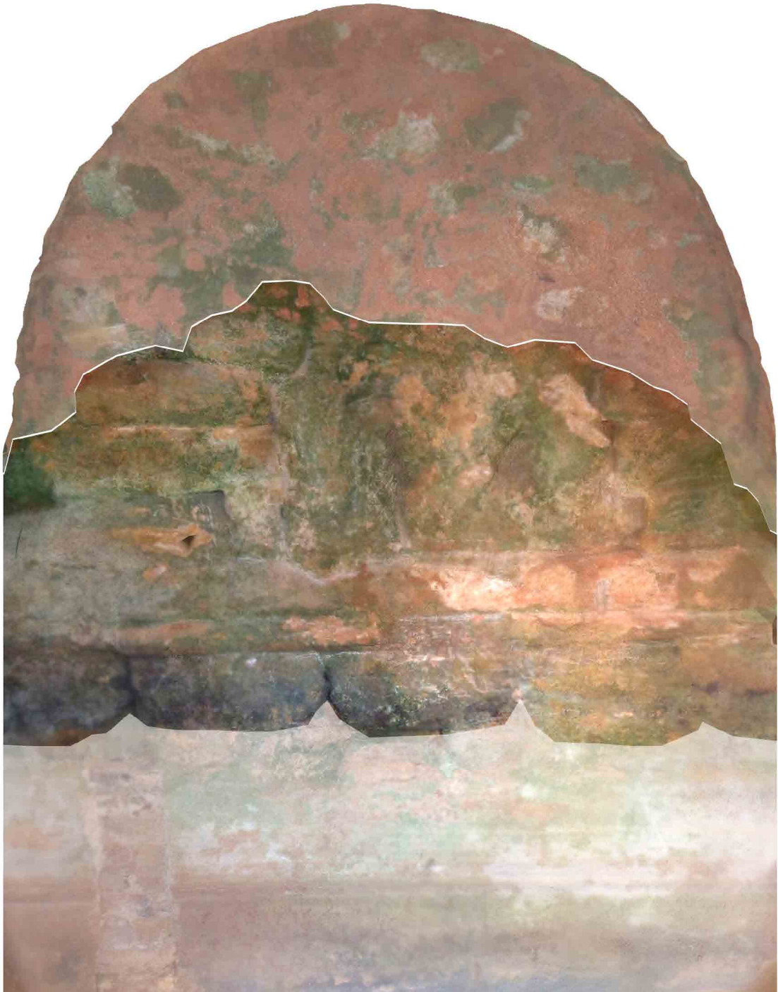
Figura 31. Resaltada la obra correspondiente a la fase altomedieval.
