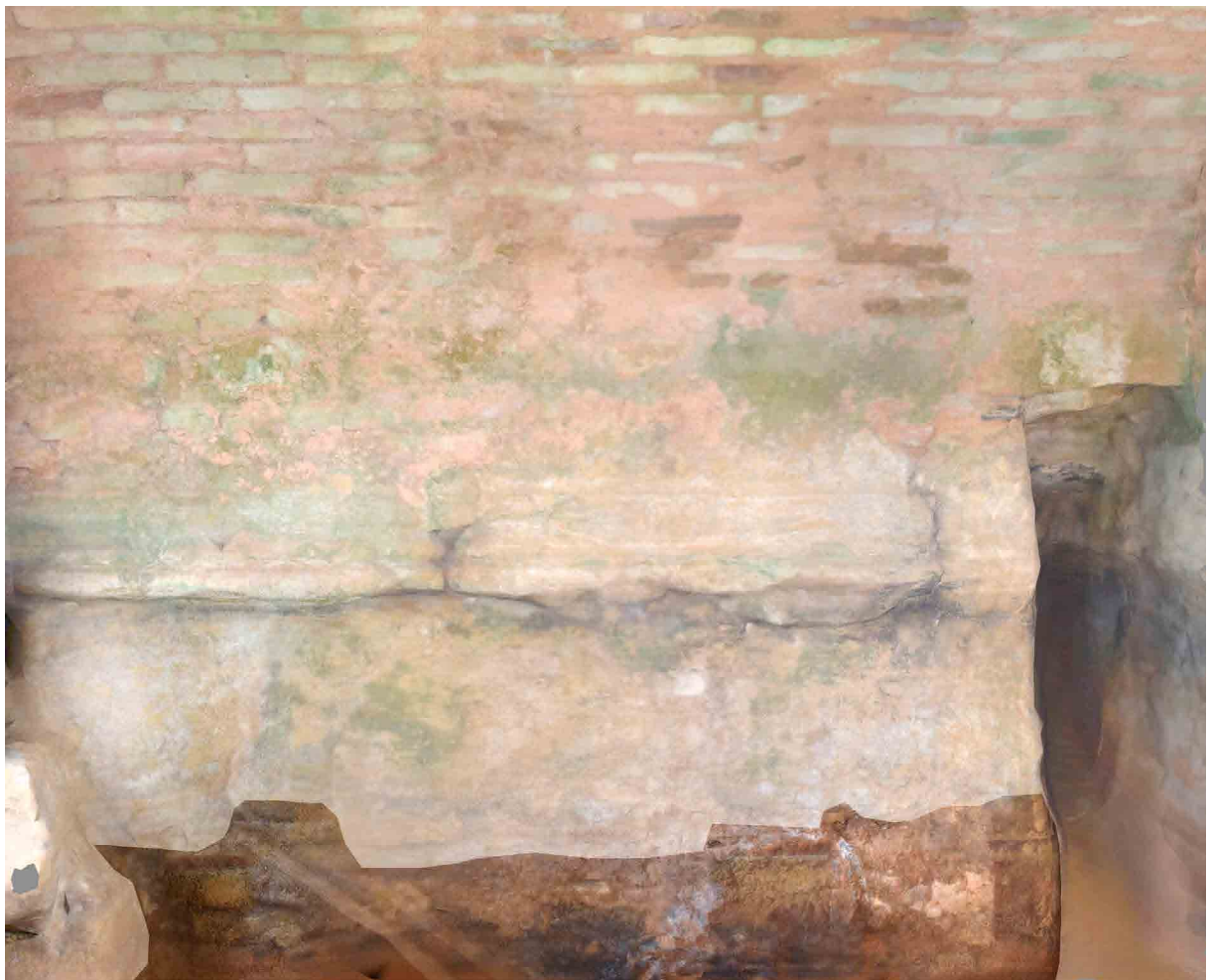
Figura 19. Resaltada la primera fase de ladrillos de la fábrica romana del paramento septentrional.
