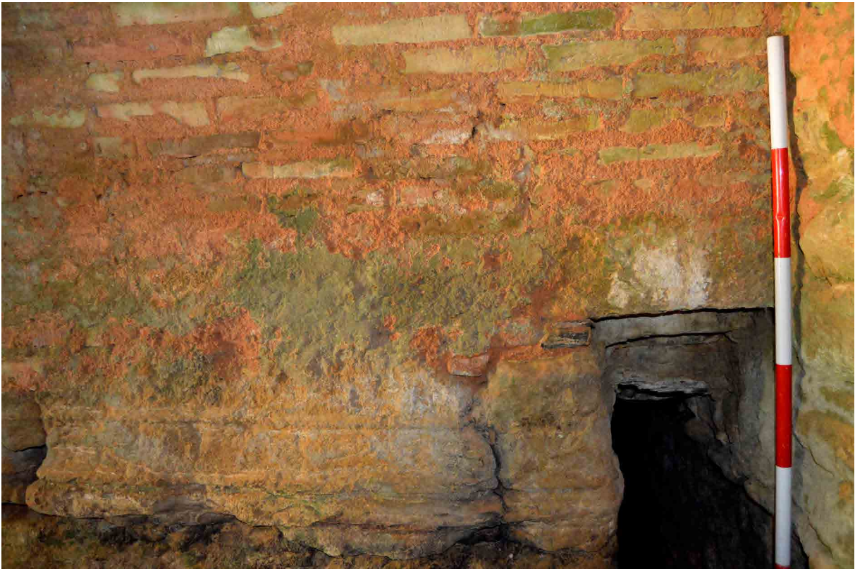
Figura 30. Sillar oriental de la segunda tongada del muro septentrional y sillarejo empleado como dintel plano de la galería norte.
