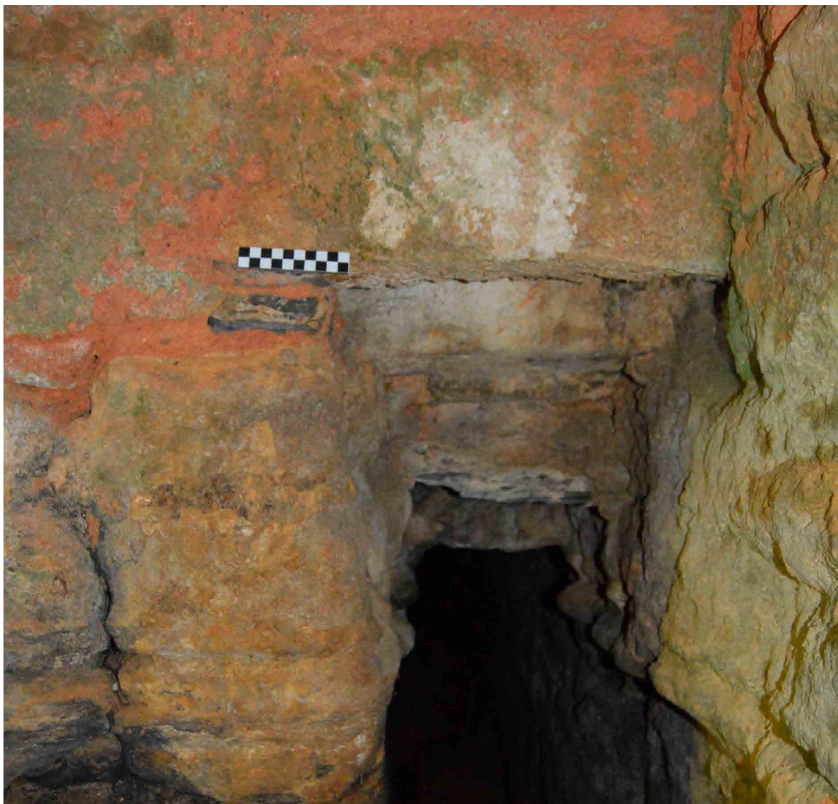
Figura 11. Uso de pizarra como elemento regularizador.
