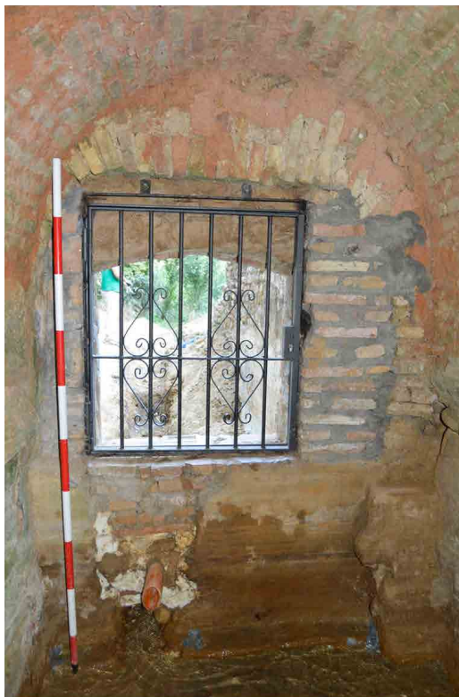
Figura 39. Arco rebajado que vino a estrechar el vano de acceso original.
