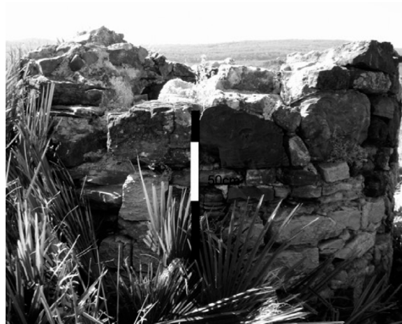
Figura 25. Pozo de resalto del acueducto de Realillo (Borau, 2015).
