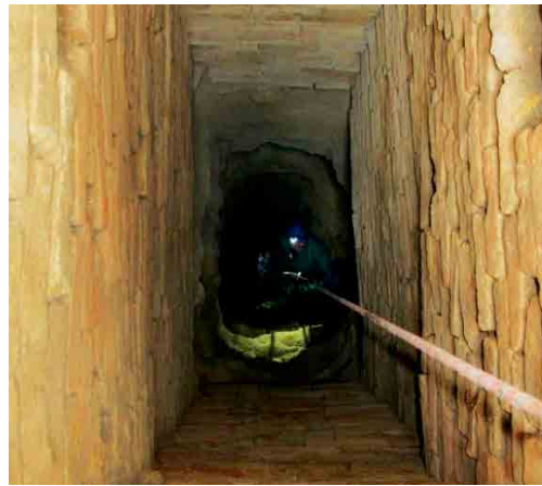
Figura 39. Tramo de la galería Puerto de Brenes (Millán Naranjo, 2015).
