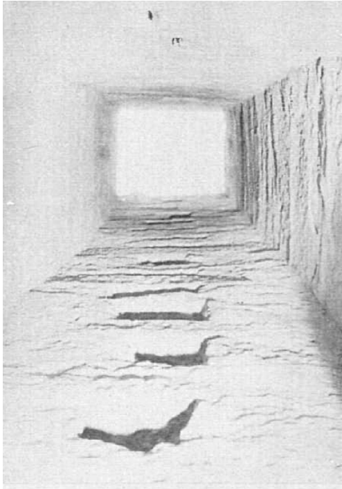
Figura 62. Spiramina del acueducto de Segobriga (Almagro Basch, 1976).
