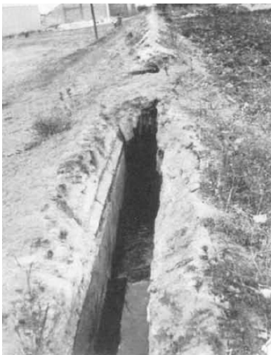
Figura 36. Tramo en zanja del acueducto de Hispalis (Fernández Casado, 1970).
