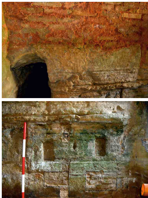
Figura 10. Sillares reutilizados para construir la mitad inferior de la cámara, se destaca (en punteado) el uso de ladrillos en la opera original constatados bajo las concreciones calcáreas en las catas realizadas.
