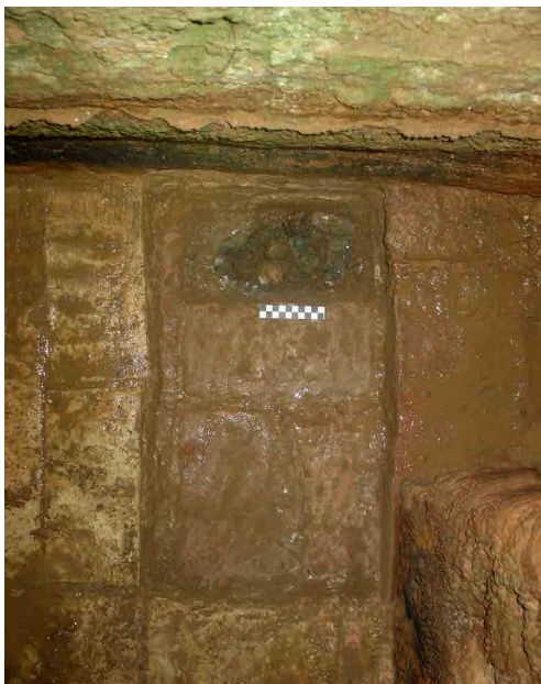
Figura 21. Suelo original de ladrillos de módulo romano justo a la entrada de la galería meridional.
