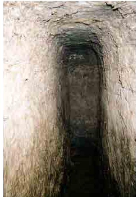
Figura 75. Galería del acueducto romano de Raschpëtzer (Kayser y Waringo, 2003).
