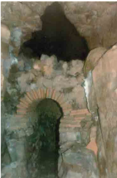
Figura 7. Galería de captación Vallehermoso (Empresa Municipal de Aguas de Córdoba).
