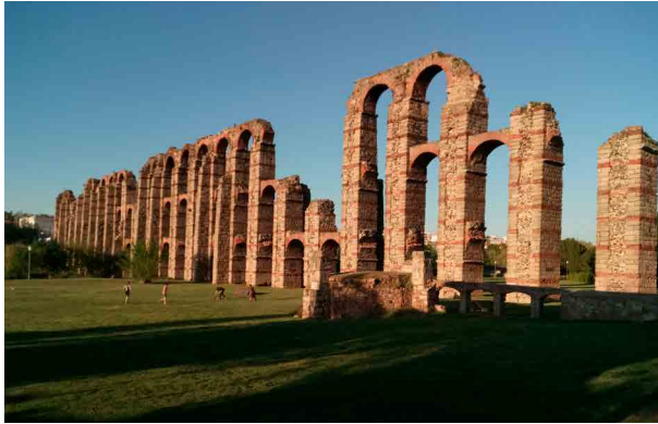
Figura 48. Arquationes sobre el río Albarregas del acueducto de Los Milagros.
