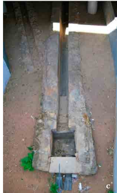
Figura 12. Castellum divisorium acueducto de la estación de autobuses (Pizarro, Berengena, 2014).
