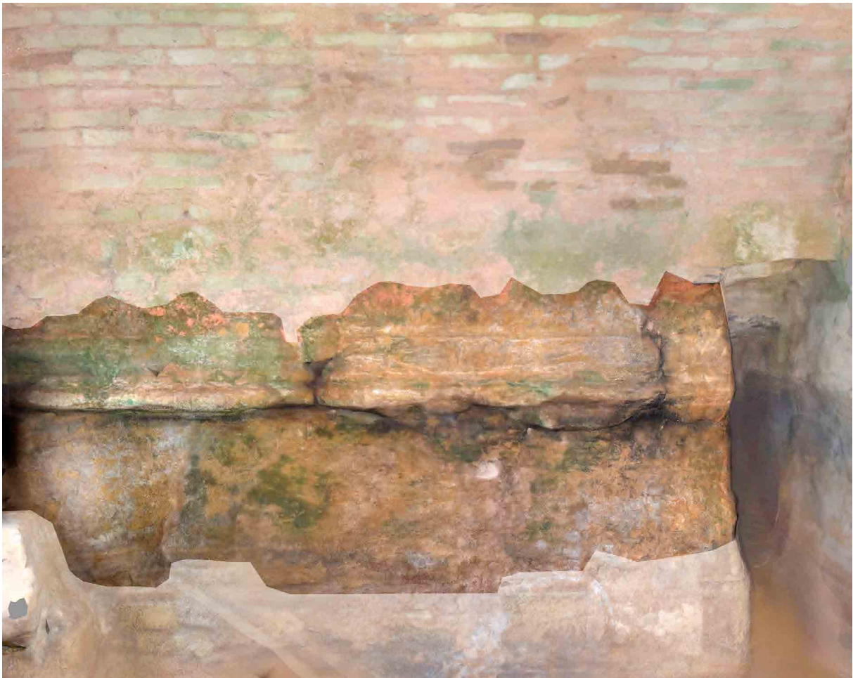
Figura 29. Resaltada la segunda fase de sillares correspondiente a la fábrica altomedieval del paramento septentrional.
