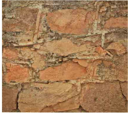
Figura 52. Acueducto de Cornalvo, detalle del encintado de mortero de las juntas entre los mampuestos de las paredes (Pizzo, 2015).
