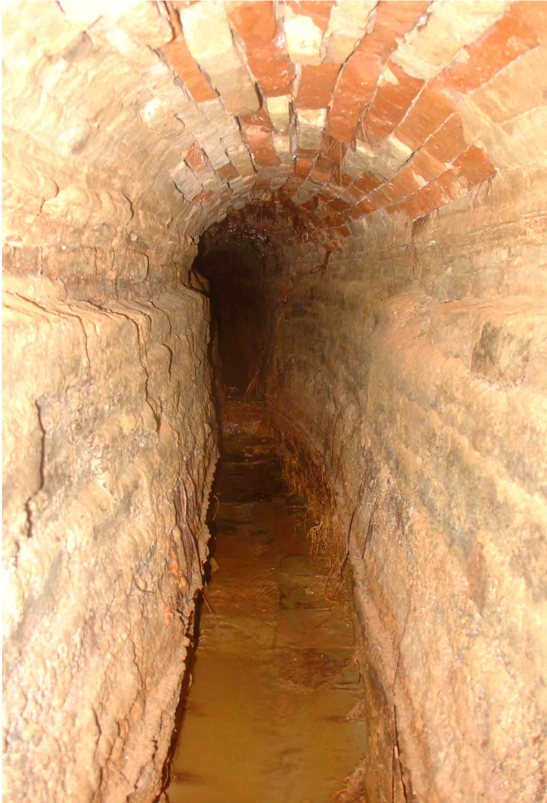
Figura 3. Detalle de una de las secciones de la galería.
