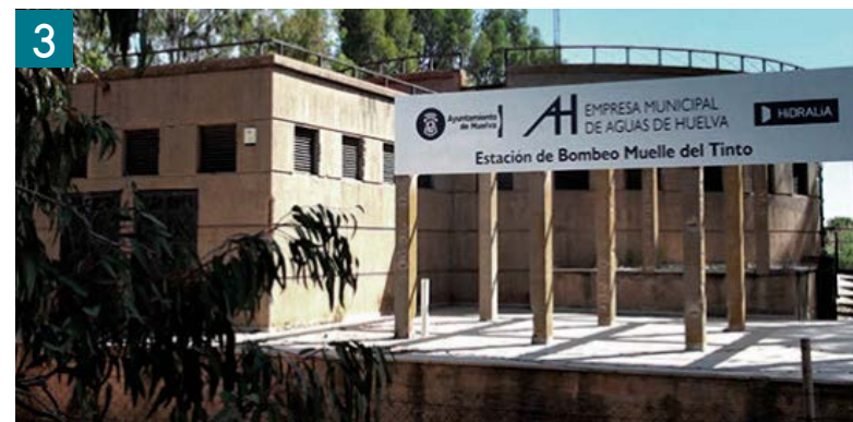
Estación de bombeo Muelle del Tinto situada en el Paseo de la Ría. ▲
