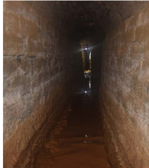
▲ Interior de galería subterránea del acueducto de la Fuente Vieja, sus dimensiones son sólo de unos 1,2 m de altura y 40 cm de anchura.
