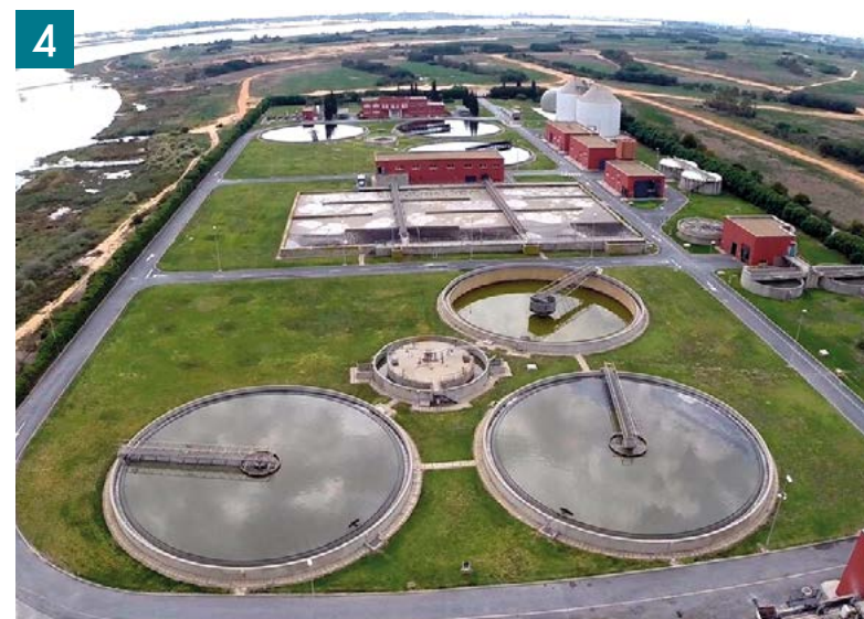
Estación Depuradora de Aguas Residuales en Marismas del Pinar. ▼
