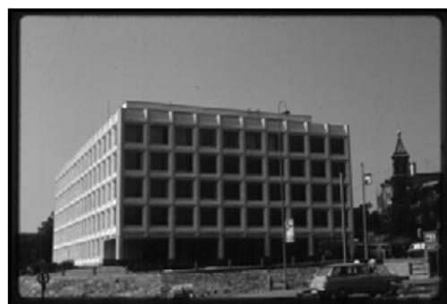
Tradición urbanística de Engels Edificio Enso-Gutzeit
