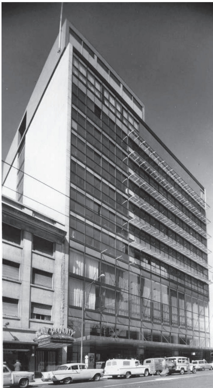
Fotógrafo: Manuel Gómez Piñeiro Teatro Municipal General San Martín, 1960 Arquitectos: Mario Roberto Álvarez, Macedonio Oscar Ruíz
