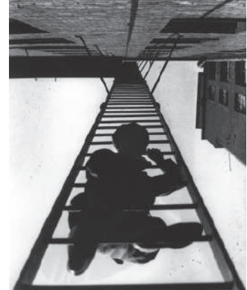
Escalera de incendios, 1925
