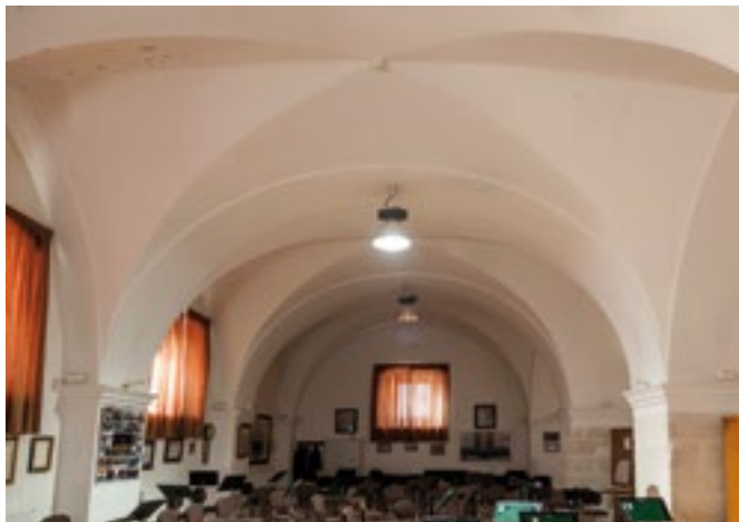
Interior con una de las dos naves del piso principal
