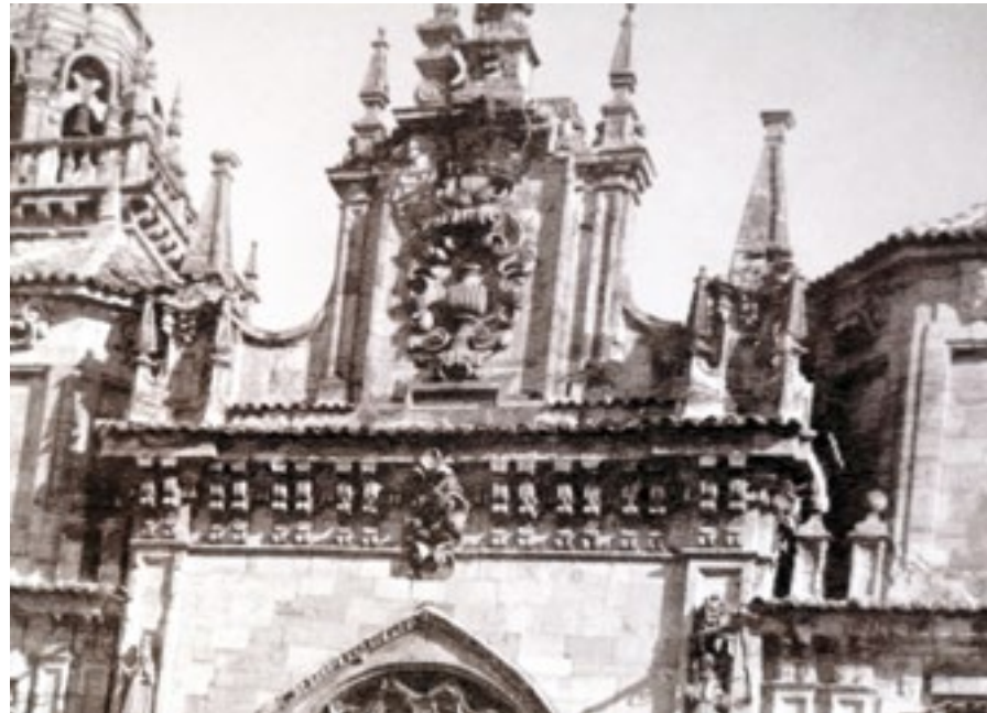
Coronamiento de la antigua fachada de la catedral
