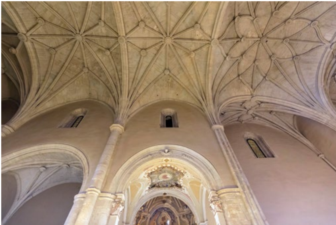
Nave de la iglesia de San Pablo y embocadura de la capilla de la Virgen del Rosario
