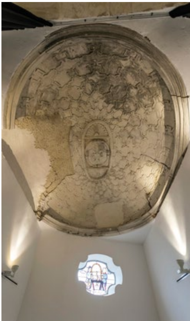
Capilla del costado meridional
