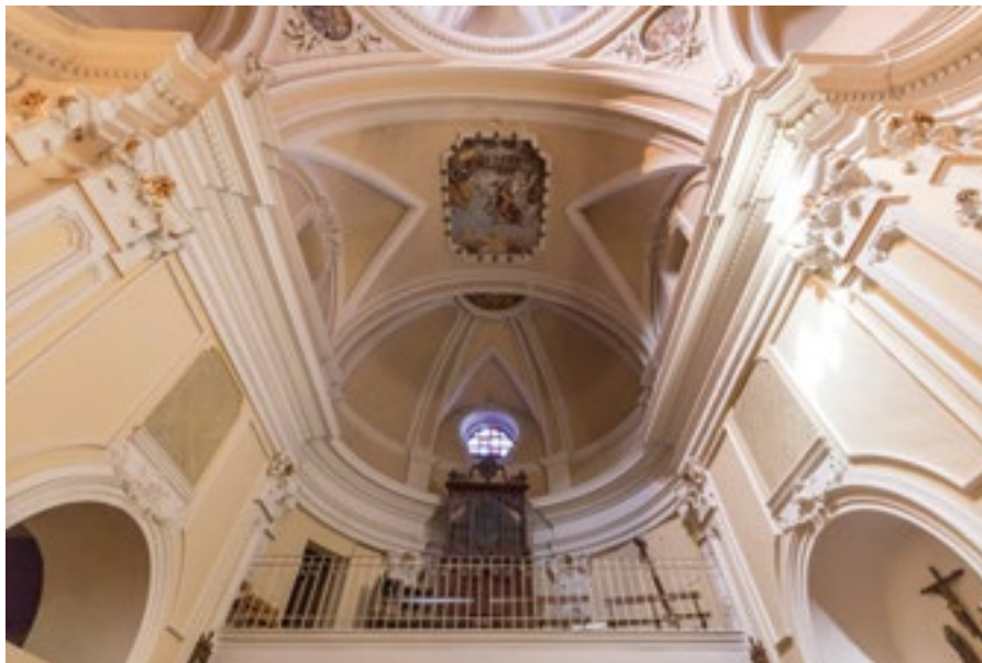
Vista hacia el coro de la iglesia
