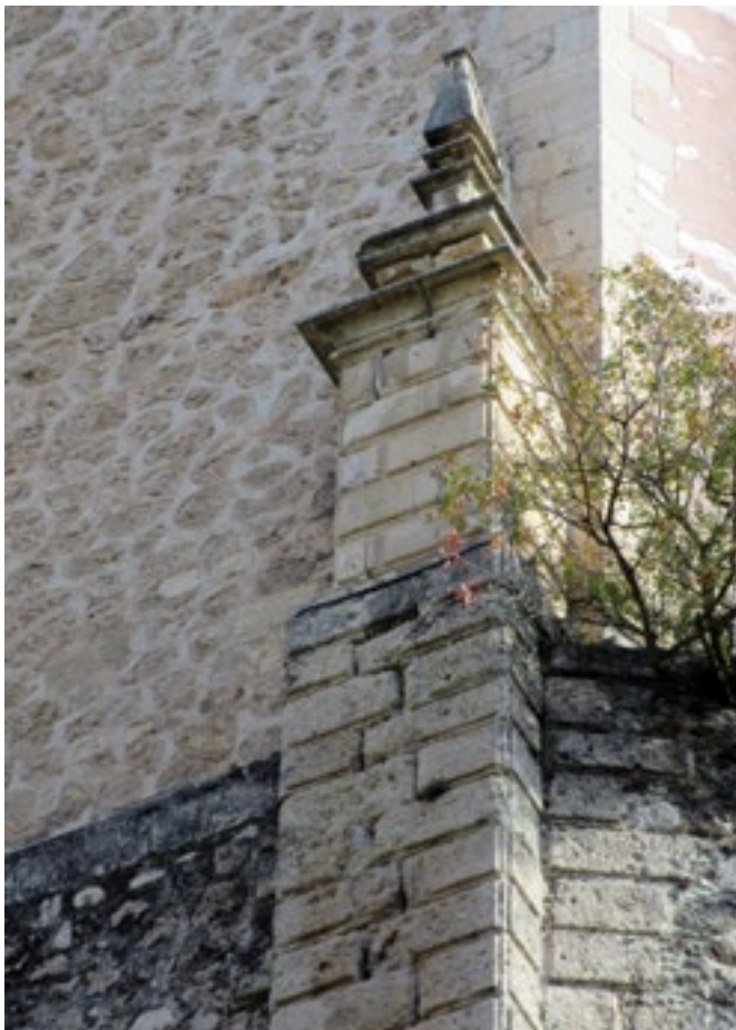
Contrafuerte con pináculo
