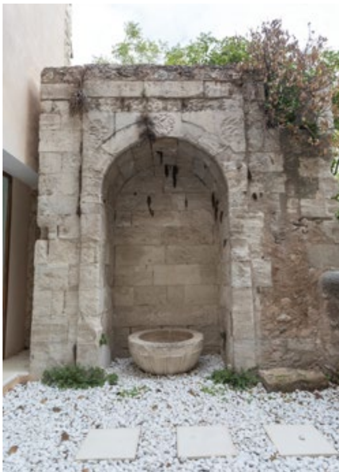
Vestigios arquitectónicos en el costado norte
