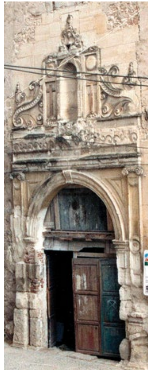
Portada antes de la restauración
