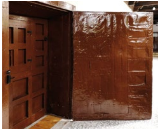
Puerta de doble hoja, en la entrada antigua del convento
