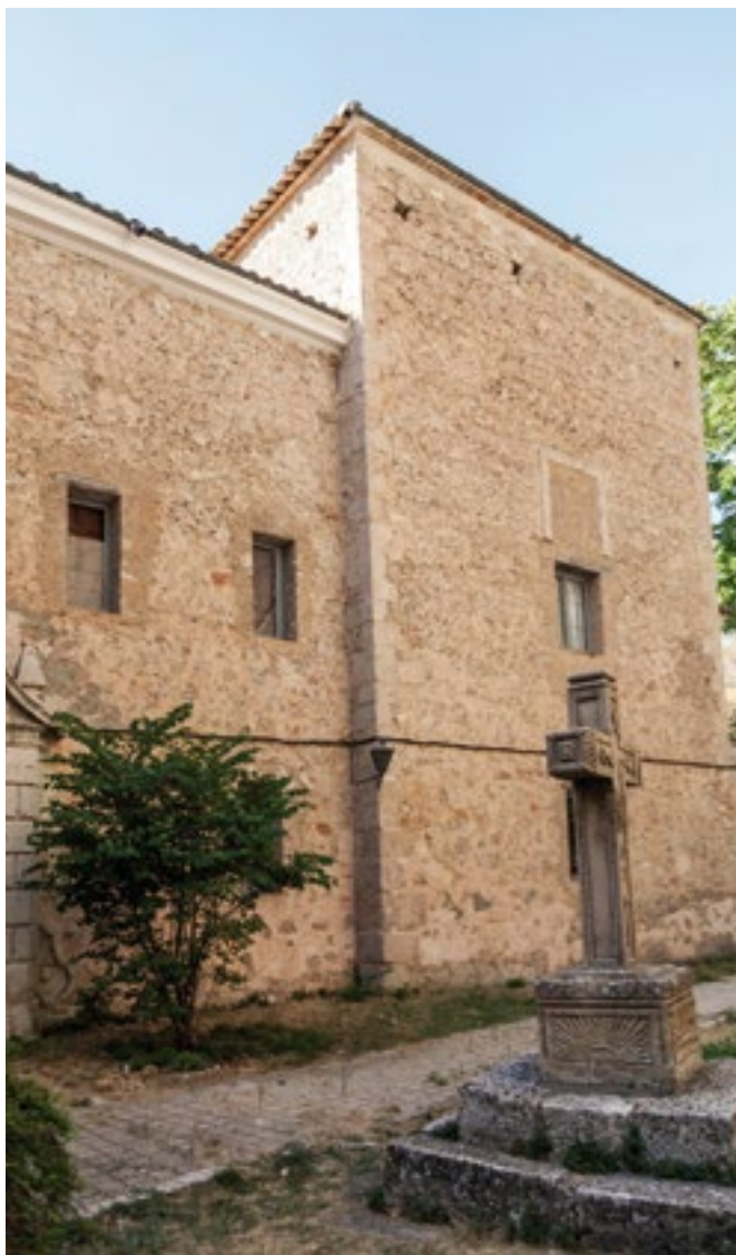
Fachada principal de la iglesia franciscana, con el atrio delante
