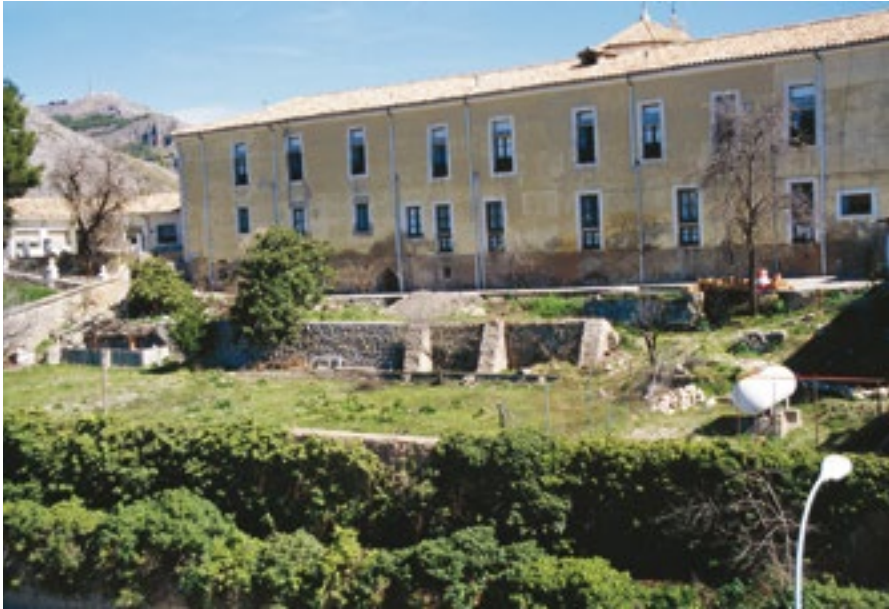
Fachada oeste del hospital de Santiago
