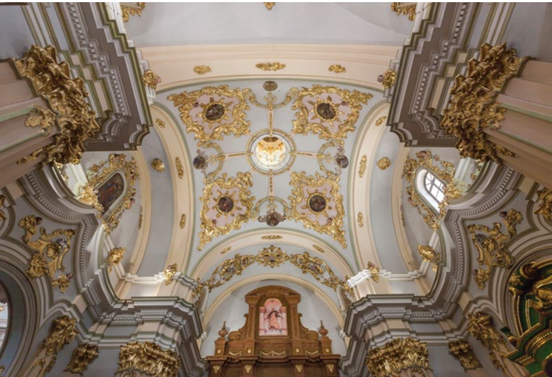
Bóveda del crucero
