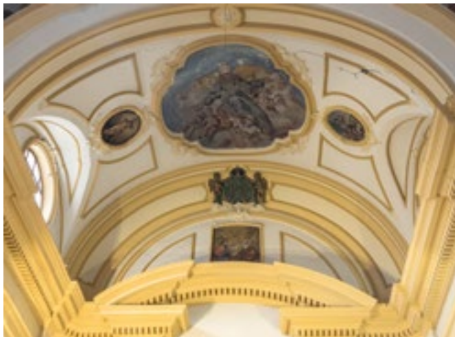
Bóveda de la capilla mayor
