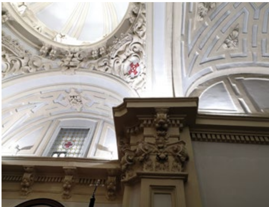
Los dos tramos de la capilla de la Soledad
