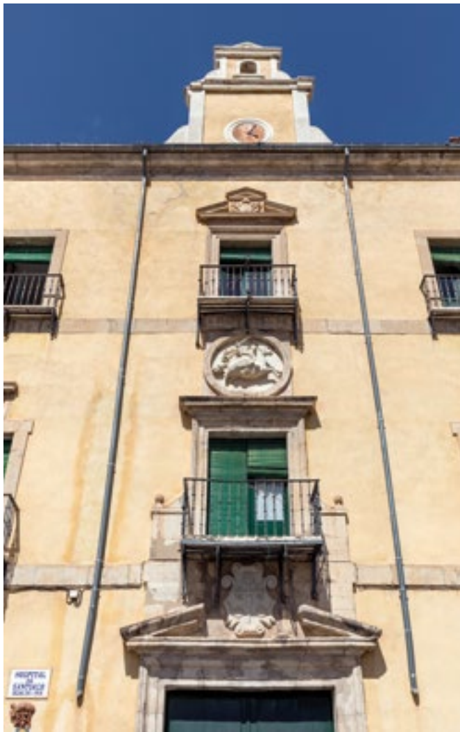
Calle central de la fachada de Francisco de Mora
