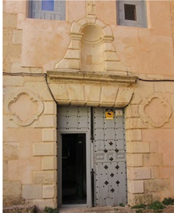
Portada del convento de Franciscanos Descalzos
