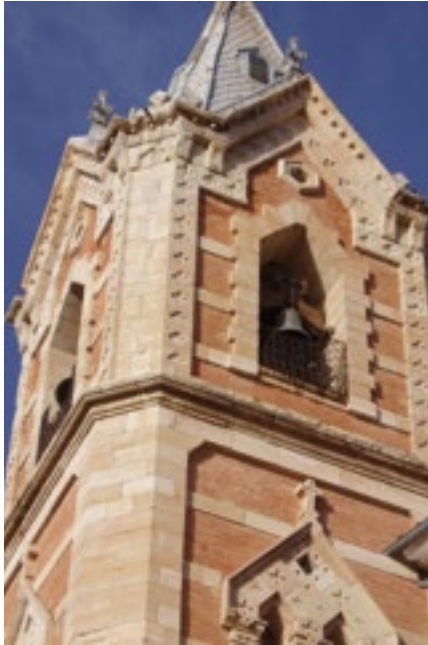
Detalle de la torre
