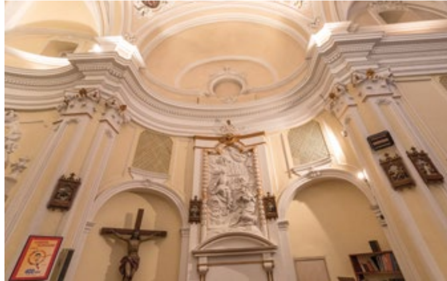
Costado del crucero
