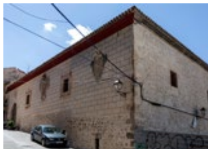
Fachadas principal y lateral
