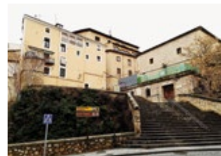
Pósito y paraje de la desaparecida puerta del Postigo en su estado actual
