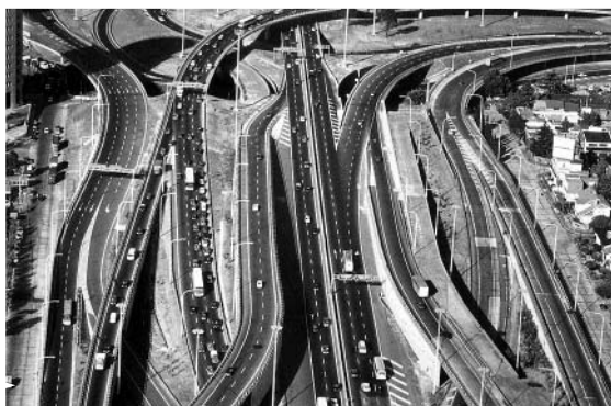
Fig. 6.39 Direccionalidad, enlaces y derroche de espacio urbano. Enlace Avda. General Paz de Buenos Aires
