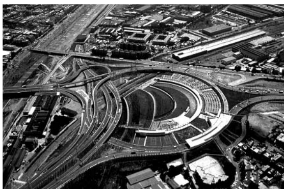
Fig. 6.51 Nudo de la Trinitat construido en 1991, con parque central e integración en la trama urbana
