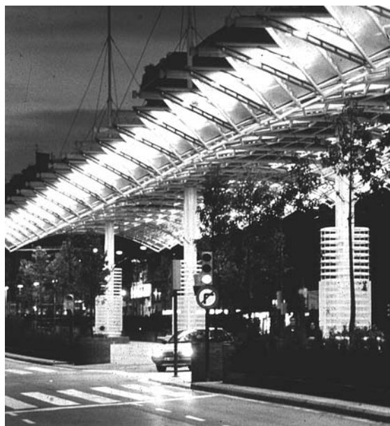
Fig. 5.24 Urbanización en calle Aragón (Barcelona)
