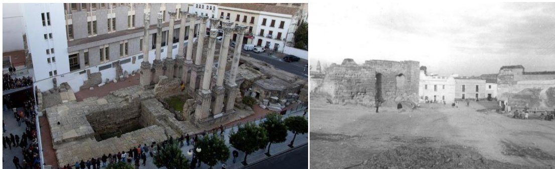
Figura 4: Templo Romano restaurado por Félix Hernández. Figura 5: Puerta de Sevilla antes de su restauración
