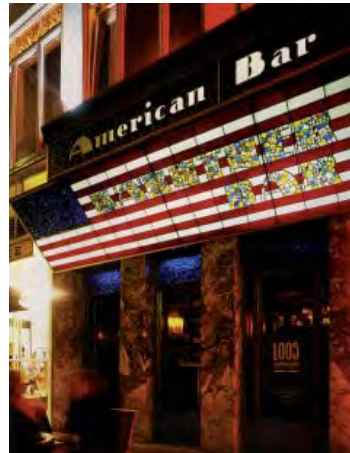
Vista actual de la façana
