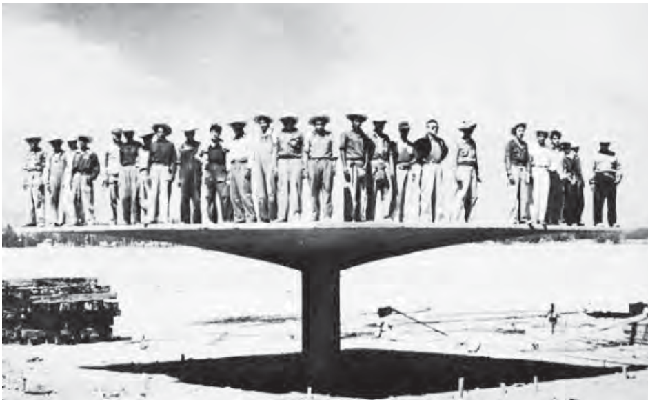
Grup d'obriers sobre una estructura paraiga de Félix Candela
