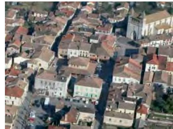
Bastide de Villeréal: vista aérea de la halle con las dependencias municipales y de la iglesia. S. XIII
