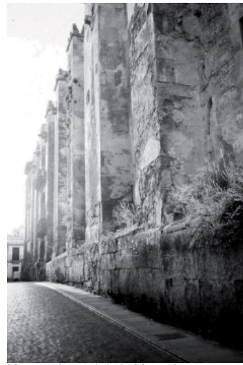
Muro perimetral de la Mezquita
