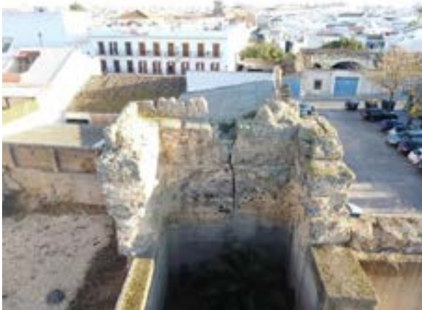
29 | Encastre de la hoja de bóveda vaída en torre 3. Adviértase su disposición a posteriori en la fábrica de la torre.
