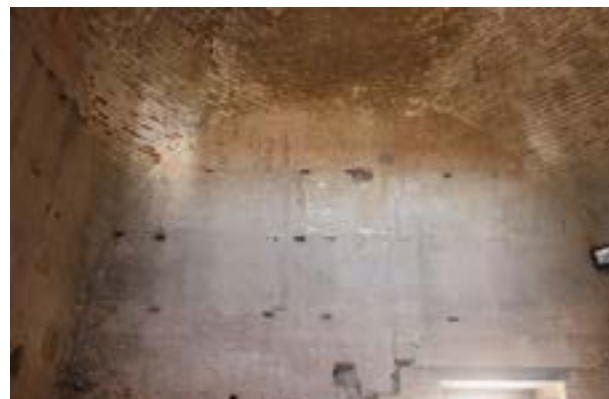
30 | Bóveda latericia inserta en la torre 1. Su construcción es independiente de la del cubo.
