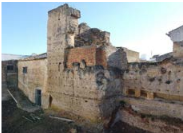
37 | Reparación con ladrillos de la esquina suroccidental de la torre 3.
