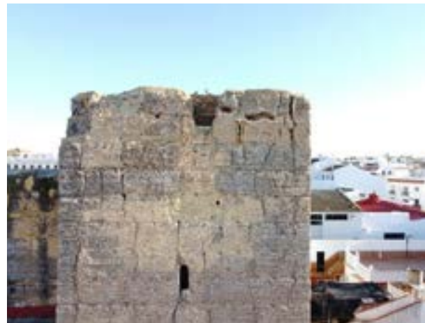
28 | Fábrica de tapial simple. Es el módulo general de la fortaleza, destacando la ausencia de cadenas de refuerzo ni de recercados de vanos, algo infrecuente en tapias de resistencia a compresión baja (aquí 60 Kg x cm)
