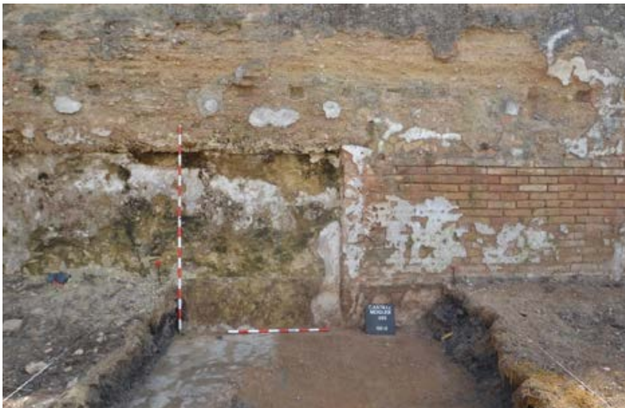
90 | Muralla exterior oeste del castillo. Terreno natural (ue 214) excavado dos metros.
