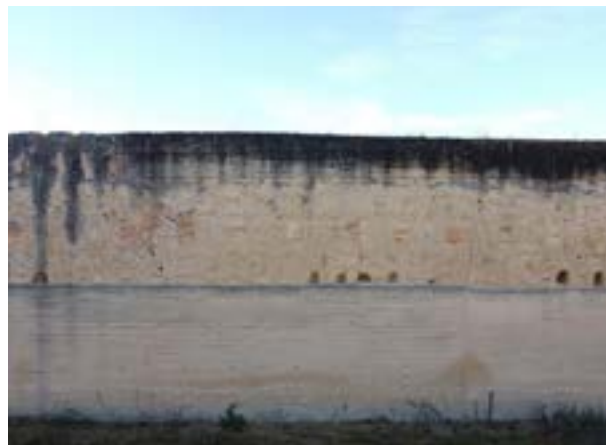
38 | Reparación con tapia nueva del lienzo meridional.
