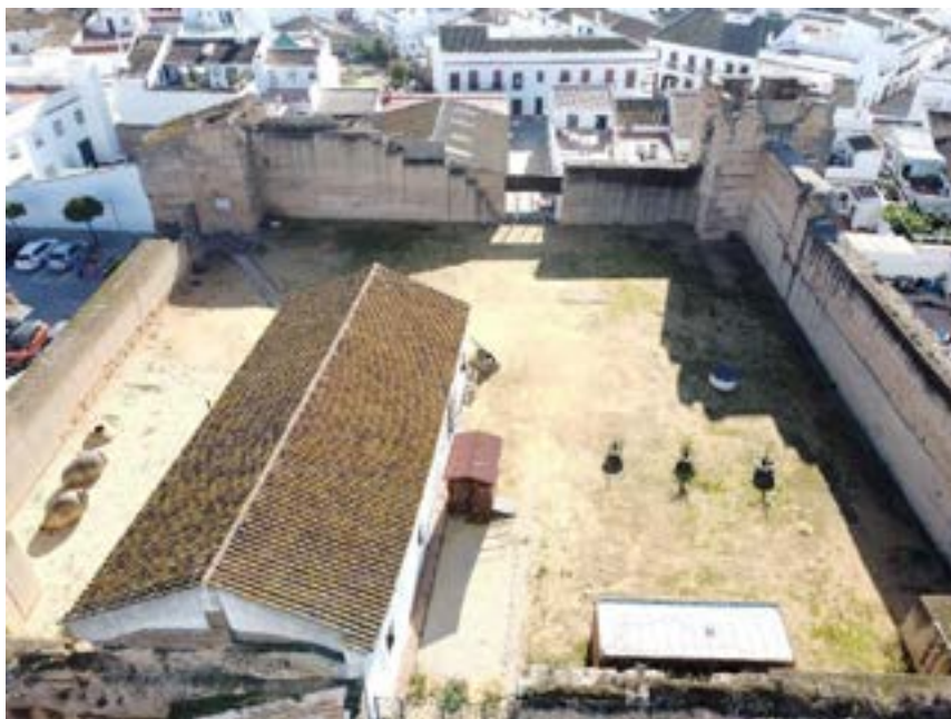
36 | Bodega reutilizada como dependencia municipal. Único resto en el interior del castillo de este período posterior a 1783.
