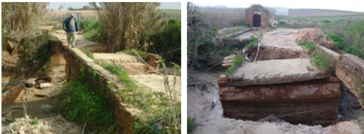
02 | La Fuente de Pinete y el puente arruinado. Fotografías de 2004.
