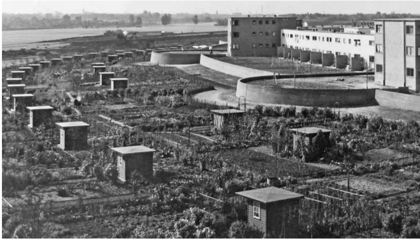
Vista dels horts d'autoproducció que voregen la Siedlung de Römerstadt a Frankfurt. Masterplan: Ernst May, Herbert Boehm, Wolfgang Bangert. Arquitectura: Ernst May, Carl-Hermann Rudloff, Karl Blattner, Gustav Schaupp, Franz Schuster. Disseny de jardins: Leberecht Migge. 1928
