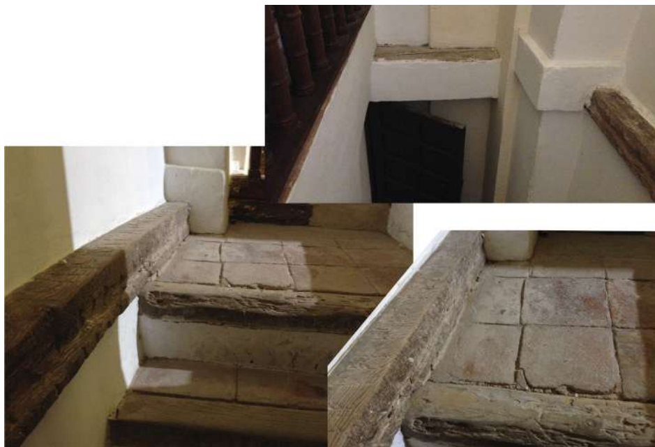
Figura.5. Desembarco a escalera de Tribuna. Detalle de atado de forjado con hendiduras en la madera.
