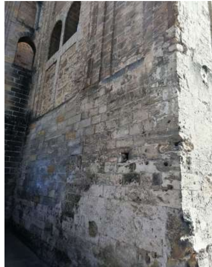
Figura 4. Palermo, la Cuba. Dettaglio della zoccolatura che rimaneva sommersa nel bacino d'acqua.
