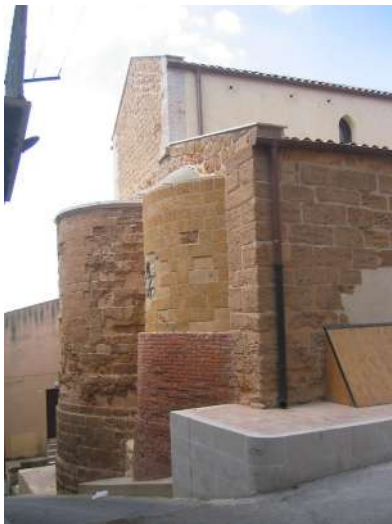
Figura 3. Prospetto nord-est successivo ai lavori di restauro del 2002-2004, Giulio Sajeve, Archivio documentazione di cantiere della Direzione dei lavori.
