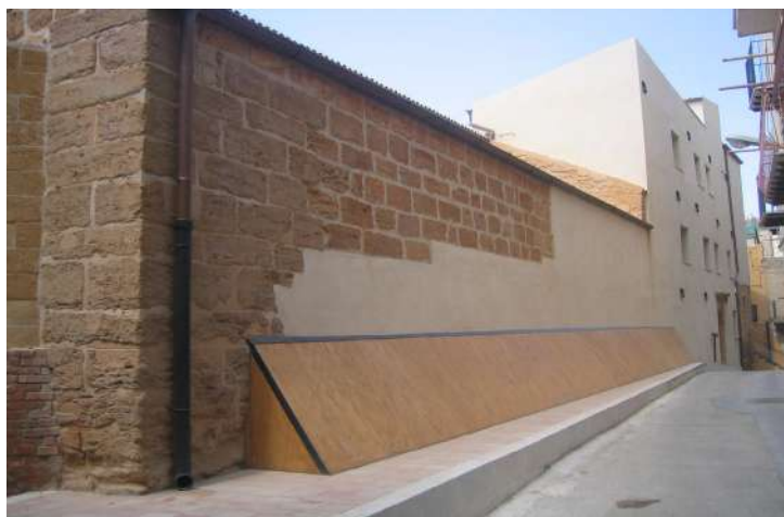
Figura 4. Prospetto nord successivo ai lavori di restauro del 2002-2004, Giulio Sajeve, Archivio documentazione di cantiere della Direzione dei lavori.
