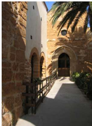
Figura 5. Vista cortile-sagrato successivo ai lavori di restauro del 2002-2004, Giulio Sajeve Archivio documentazione di cantiere della Direzione dei lavori.
