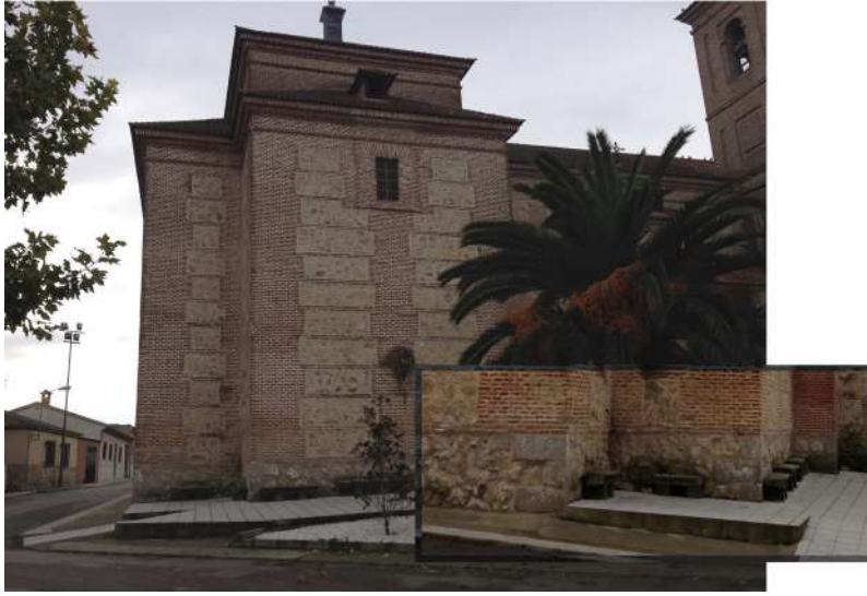
Figura. 3. Fragmento de la fachada norte y detalle de composición de fachada.
