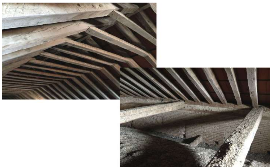
Figura 6. Estructura de par y nudillo de la cubierta de la nave principal.
