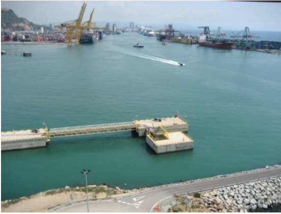
Figures 4.17 i 4.18 Mareògrafs radar al Port de Barcelona (esquerra) i al Port d'Eivissa (dreta). Font: Puertos del Estado [33]
