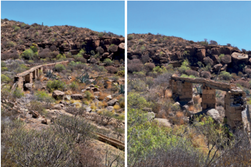
Conducciones de agua realizadas con piedra de zahorra, hoy abandonadas
