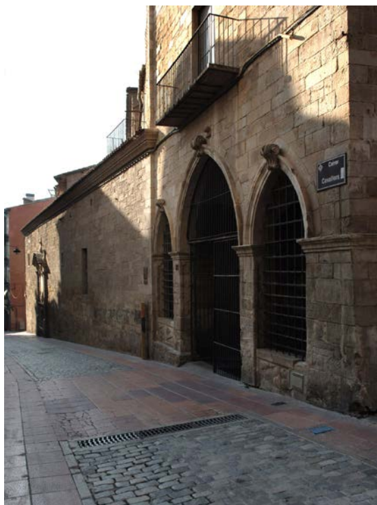
Edificio del Roser
