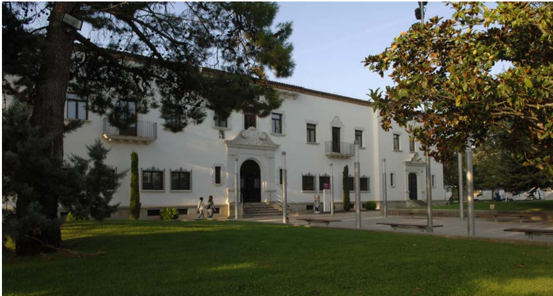
Edificio central del campus de la ETSEA, actualmente ETSEAFIV
