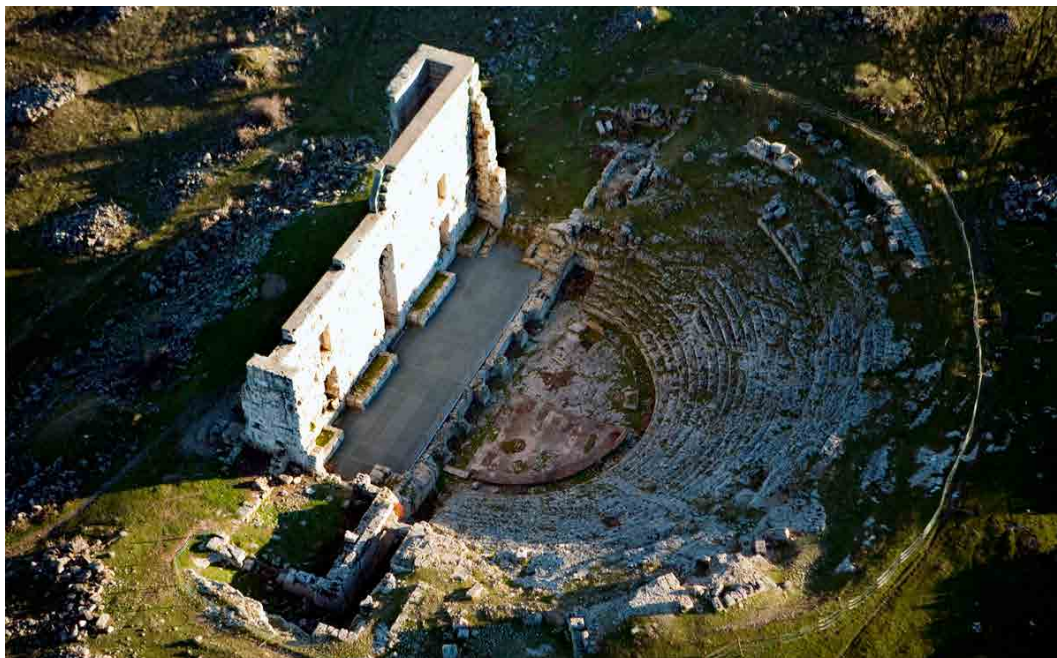
Figura 10. Vista Aérea del Teatro de Acinippo (Ronda, Málaga) http://www.juntadeandalucia.es/cultura/rutasteatro/galeria_a/galeria_167.jpg
