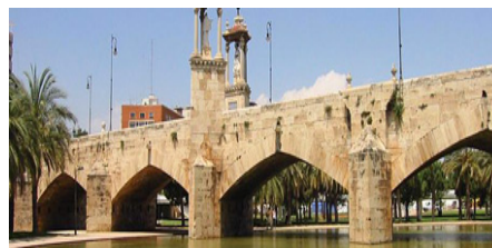
Puente del Mar (1596)
