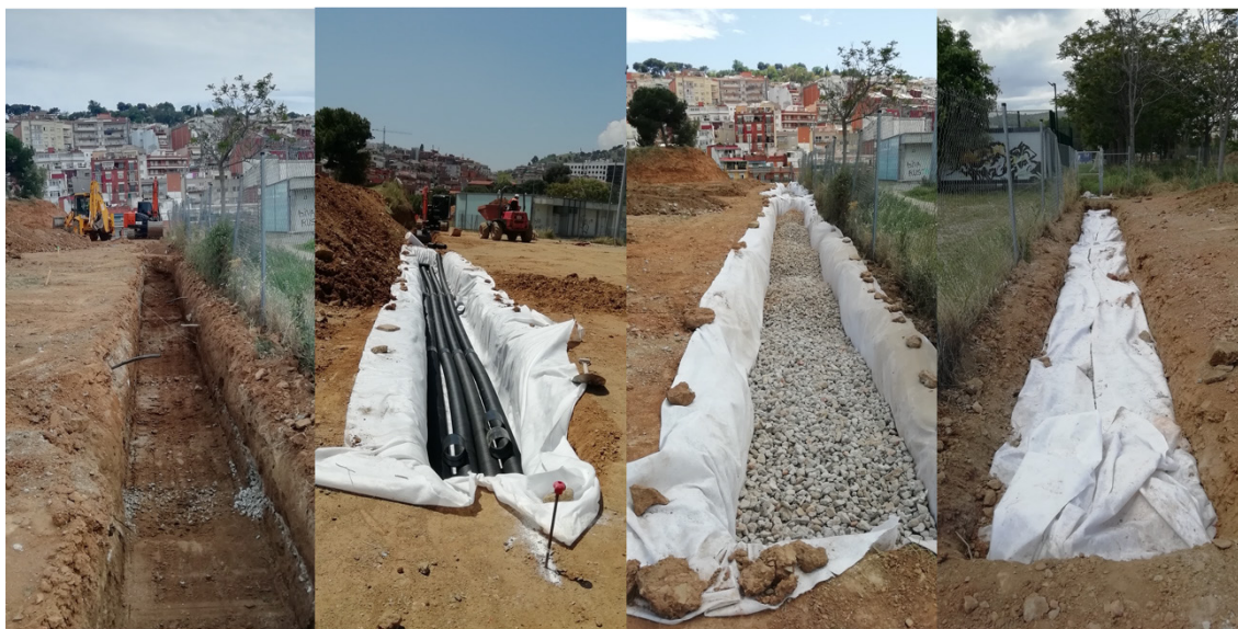
Fig. 7 La Campa es un paisaje resiliente. Detalles de ejecución de las canales verdes (Fuente: Elaboración propia,2019)
