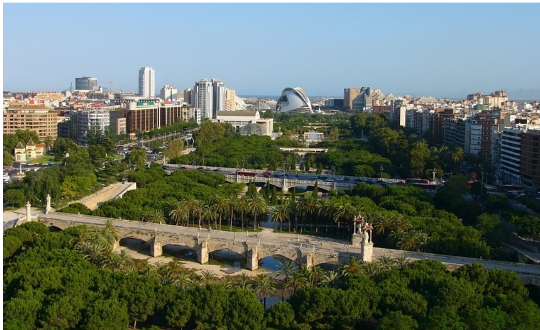
Imagen 01. Estado actual del cauce. Integración en la Forma Urbana
