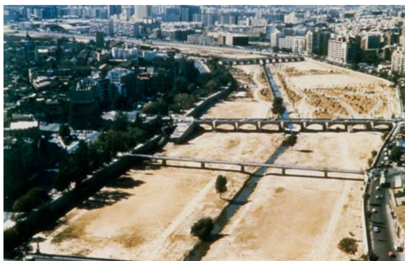
Fig. 06 Cauce antiguo seco tras las obras de desvío. Imagen 1987
