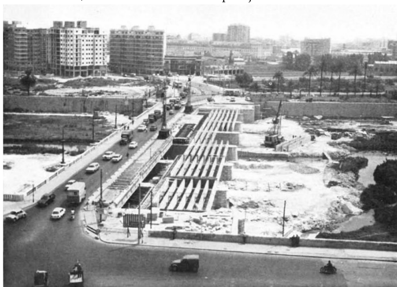
Fig.09 Desdoblamiento Puente Ángel Custodio año 1967. Fuente: CSIC Informes de Construcción Vol. 20 nº 196
