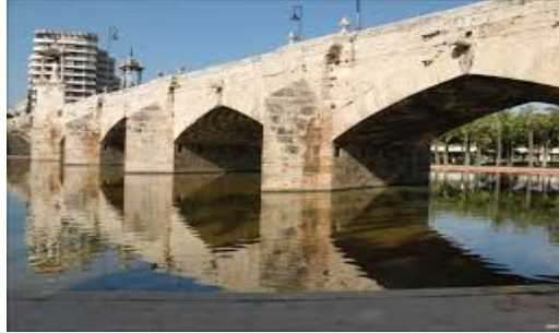
5- Puente del Mar
