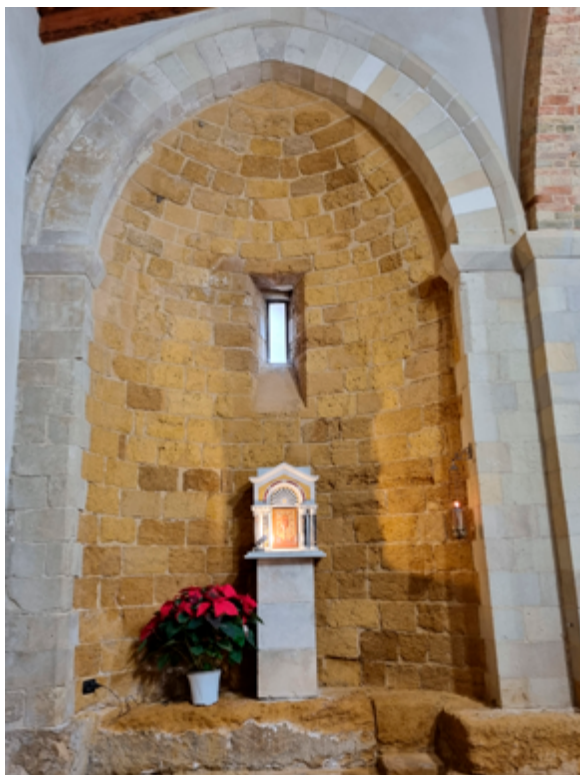
Fig. 97. Veduta interna chiesa dopo l'intervento di restauro del 2002. Arco ogivale abside realizzato dal Valenti. Fonte: Autrice.
