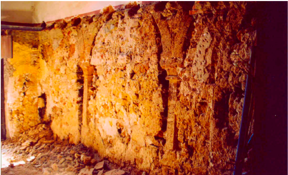
Fig. 38. Portico medievale rinvenuto nell'ex vano Sacrestia. Fonte: Archivio Studio Sanzo-Sajeva.
