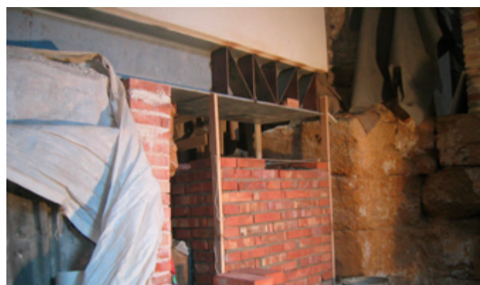
Fig. 171. Fase di lavorazione successiva alla posa in opera delle travi HEA. Fonte: Archivio studio Sanzo Sajeva.
