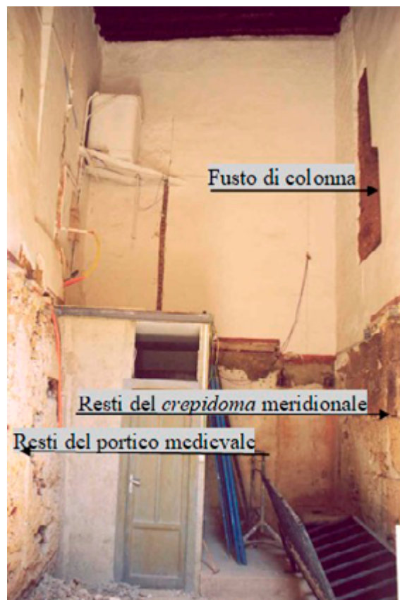
Fig. 192. Vano Sacrestia dopo la rimozione del solaio intermedio. Fonte: Ing. Giulio Sajevo.
