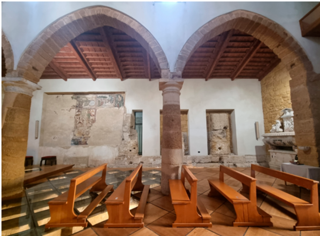
Fig. 17. Veduta di due tronchi dimezzati delle colonne sud del tempio greco. Fonte: Autrice
