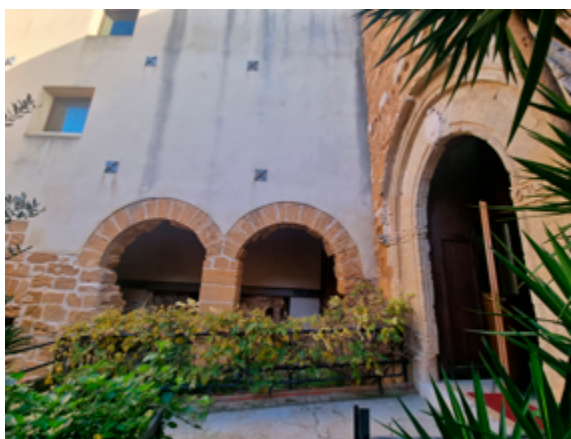
Figg. 159-160. Prospetto sud Antiquarium su area sagrato, prima e dopo i lavori di restauro. Fonte: Autrice.
