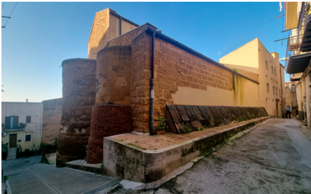
Fig. 10. Vista lato nord-est chiesa Santa Maria dei Greci. Fonte: Autrice
