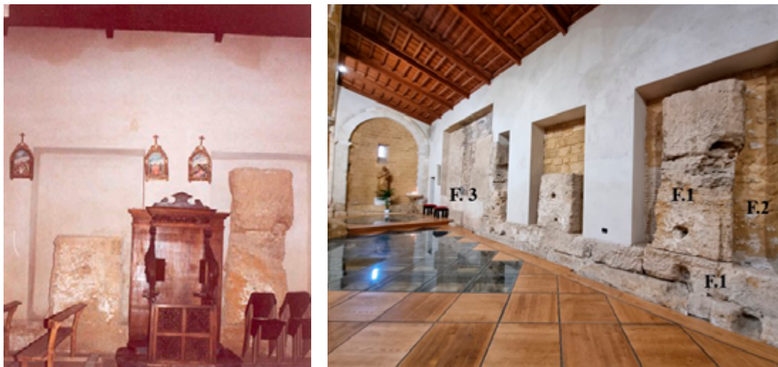
Figg. 47-48. Parete meridionale chiesa, prima e dopo l'intervento di restauro. Fonte: Autrice.
