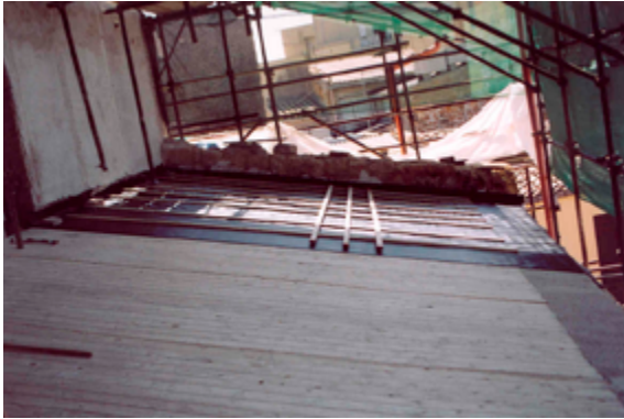
Fig. 223-224. Copertura navata laterale della chiesa dopo l'intervento di restauro. Fonte: Ing. Giulio Sajevo.
