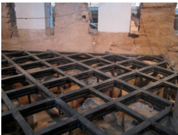
Fig. 209. Vista struttura pavimentazione chiesa. Fonte: Ing. Giulio Sajeva.
