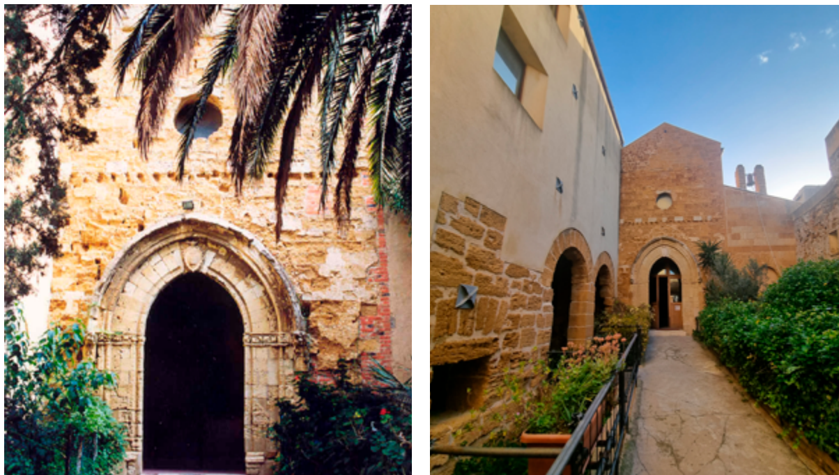
Fig. 190-191. Prospetto ovest Chiesa, prima e dopo l'intervento di restauro. Fonte: Autrice.
