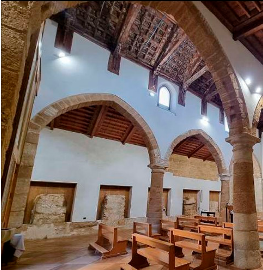
Fig. 16. Veduta dei tronchi dimezzati delle cinque colonne del tempio greco poste sul lato nord. Fonte: Autrice
