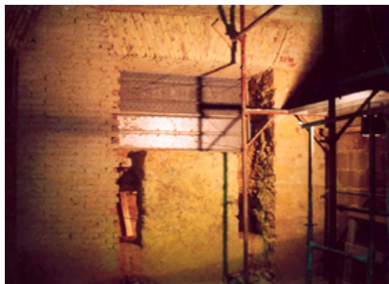
Fig. 200. Piattabanda ultimata. Fonte: Ing. Giulio Sajeve.
