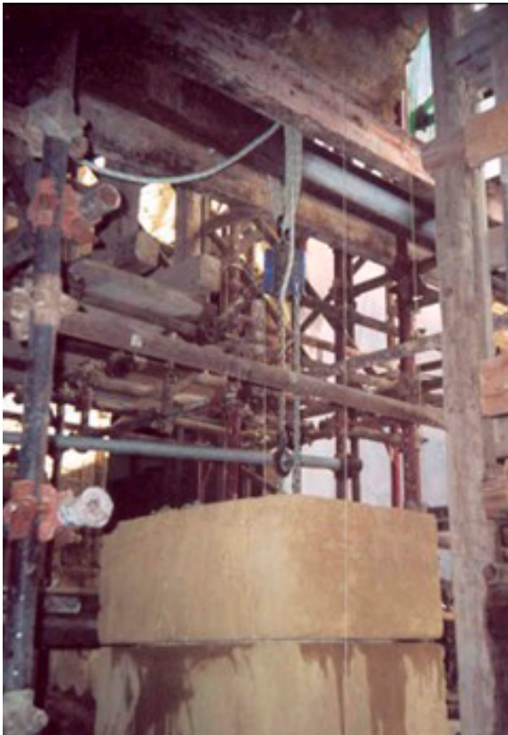
Fig. 165-166. Fasi lavorative di ricostruzione piedritto di sostegno archi Antiquarium . Autore: ing Giulio Sajeve.
