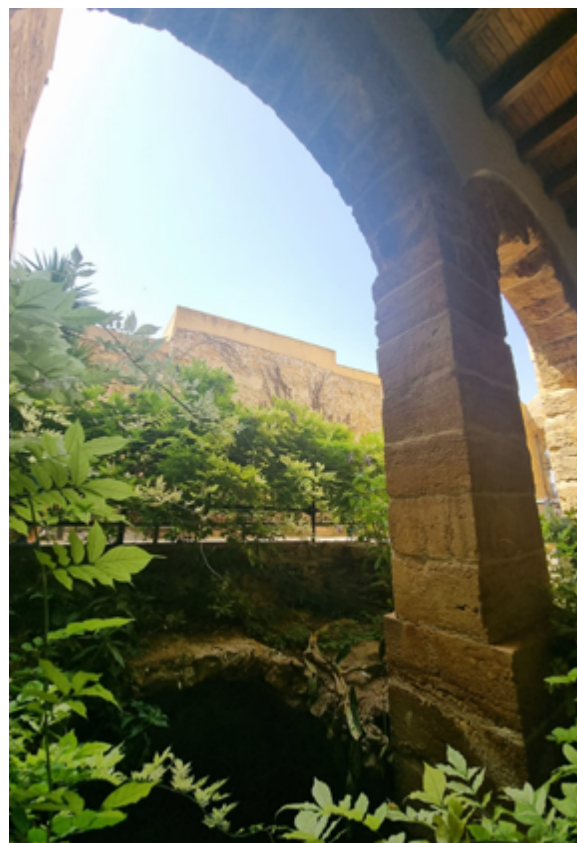
Fig. 167-168. Piedritto di sostegno archi Antiquarium , dopo l'intervento. Fonte: Autrice.
