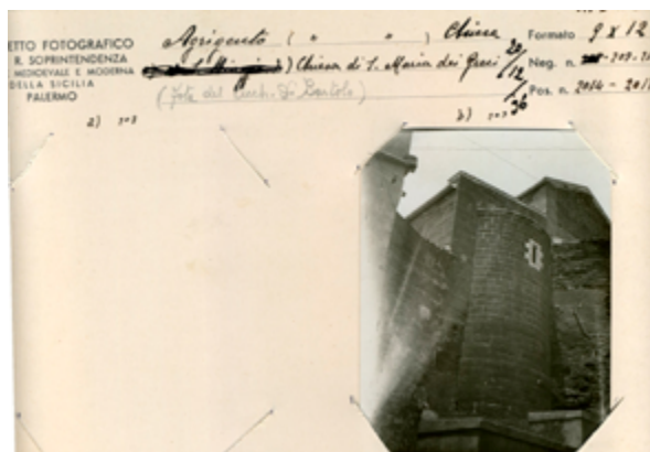
Fig. 98. Veduta angolo sud-est chiesa dopo l'intervento di restauro del Valenti. 20.12.1936. Fonte: Archivio fotografico Soprintendenza di Palermo.
