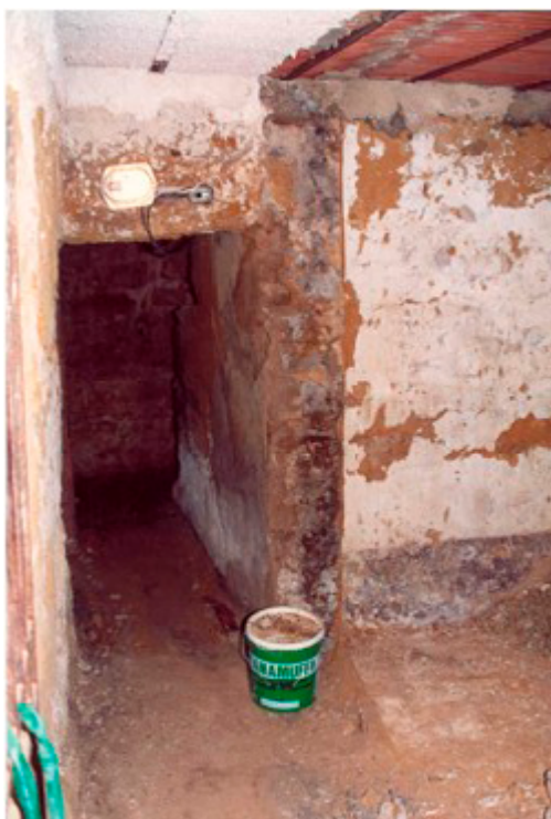
Fig. 30. Vano 1. Accesso alla galleria che conduceva al crepidoma, prima dell'intervento di restauro. Fonte: Archivio Studio Sanzo-Sajeva.
