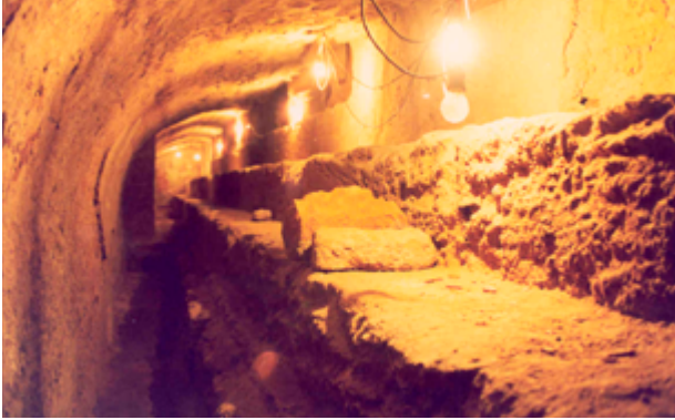
Fig. 178. Vista crepidoma prima dell'intervento di restauro. Fonte: Archivio studio Sanzo-Sajeva.
