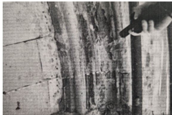
Figg. 140-141. Trattamento pulitura laser e trattamento di pulitura aeroabrasivo con microsabbatrice. Fonte: Archivio studio Sanzo-Sajeva.
