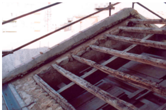
Fig. 222. Vista copertura Chiesa prima dell'intervento di restauro. Fonte: Ing. Giulio Sajeva.
