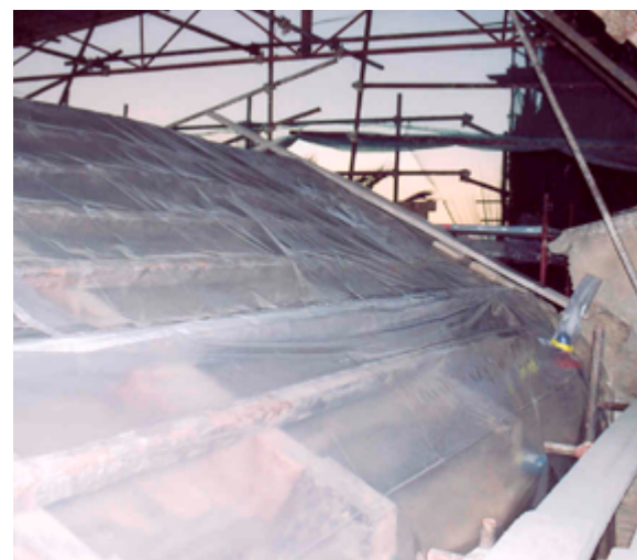
Fig. 226. Vista copertura navata centrale durante i lavori di sanificazione. Autore: Ing. Giulio Sajevo. Fonte: Archivio studio Sanzo Sajevo.
