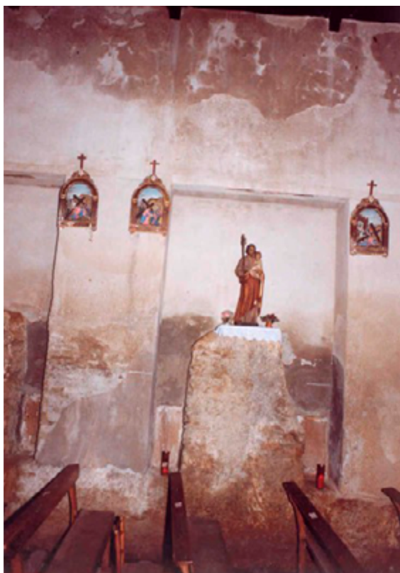
Figg. 195-196. Resti colonne peristasi nord tempio, prima dei lavori e dopo la rimozione dell'intonaco. Fonte: Ing. Giulio Sajeva.
