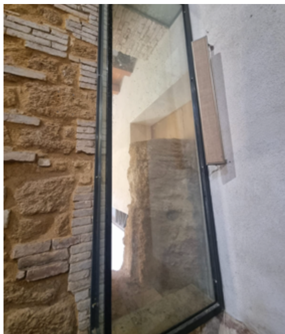
Fig. 219. Messa in luce colonna peristasi nord. Fonte: Autrice.
