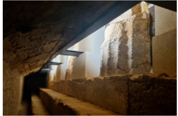
Fig. 179. Vista crepidoma dopo l'intervento di restauro. Fonte: Autrice.
