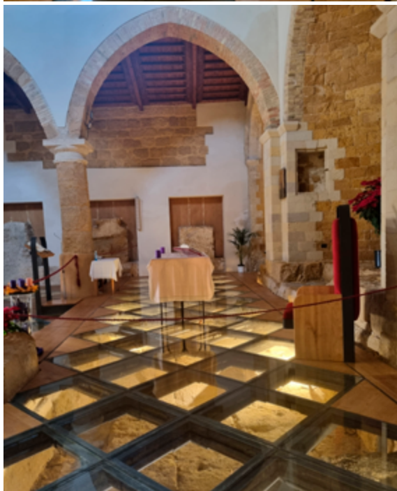
Fig. 217-218. Nuova pavimentazione in acciaio, legno e vetro. Fonte: Autrice.
