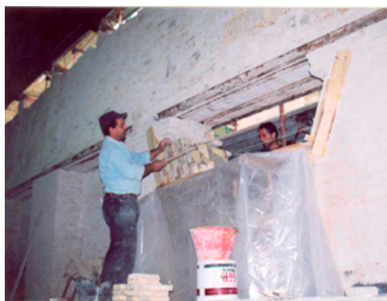
Fig. 197. Fasi di realizzazione delle piattabande. Fonte: Ing. Giulio Sajeva.
