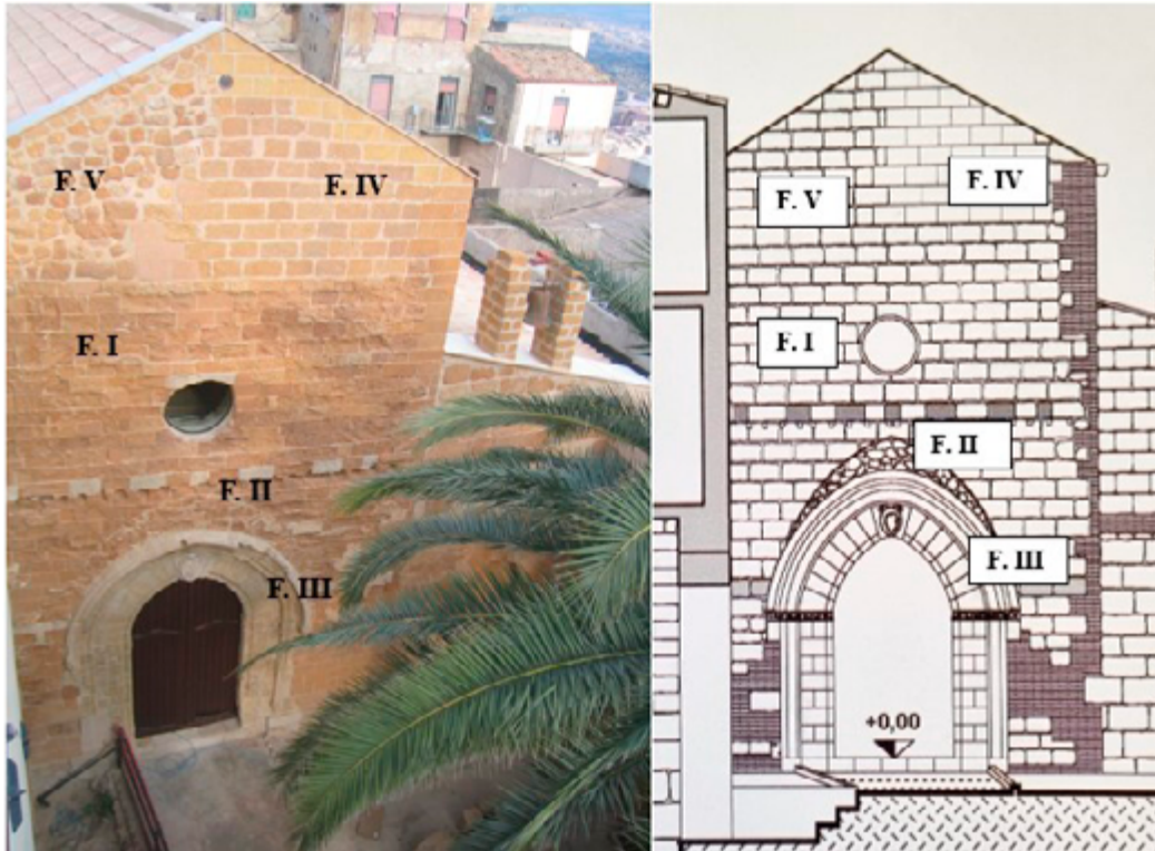
Fig. 42. Prospetto principale della chiesa con indicazione delle principali fasi evolutive. Elaborazione grafica dell'Autrice.
