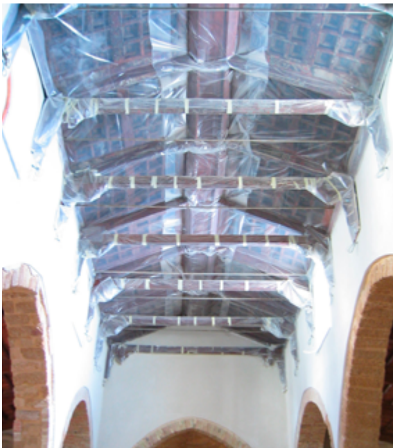
Fig. 227. Copertura navata centrale della chiesa durante i lavori di sanificazione. Fonte: Ing. Giulio Sajevo.
