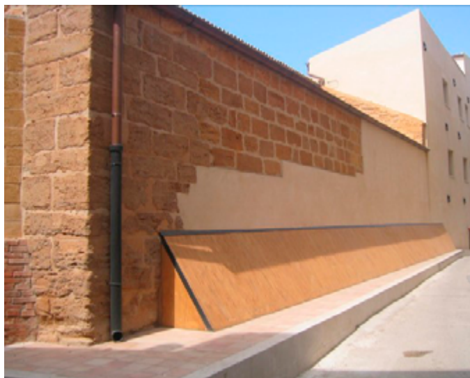
Fig. 244. Prospetto nord della chiesa sulla via Santa Maria dei Greci. Rivestimento provvisorio in legno a protezione del cunicolo sottostante la via, che custodisce i resti del Crepidoma nord del tempio greco. Fonte: Autrice.
