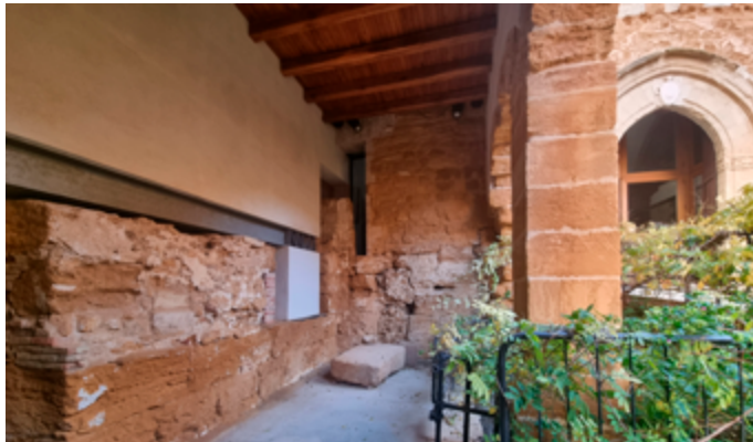
Fig. 172. Area ingresso Crepidoma dopo i lavori di restauro. Fonte: Autrice.
