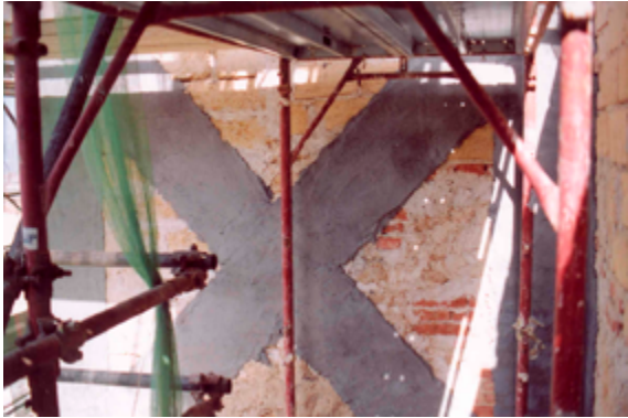
Fig. 184. Fibre di carbonio applicate sulla parete torre Antiquarium . Fonte: Archivio Studio Sanzo-Sajeva.
