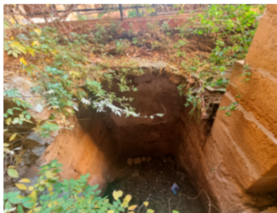
Fig. 116. Chiesa di Santa Maria dei Greci. cisterna rinvenuta tra il vano 1 e il cortile-sagrato. Fonte: Autrice.
