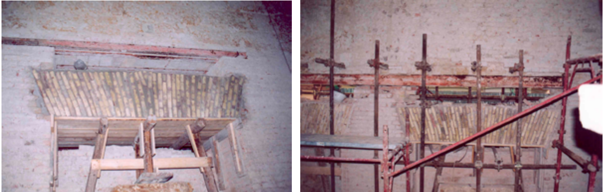
Figg. 198-199. Fasi di realizzazione delle piattabande. Fonte: Ing. Giulio Sajeve.
