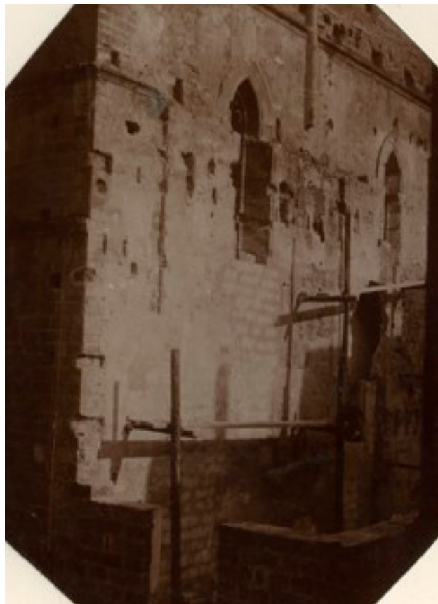
Fig. 59. Ingrandimento Fig. 58 Agrigento, Chiesa di S. Maria dei Greci, veduta esterna del Cappellone. Fonte: Archivio fotografico Soprintendenza di Palermo.
