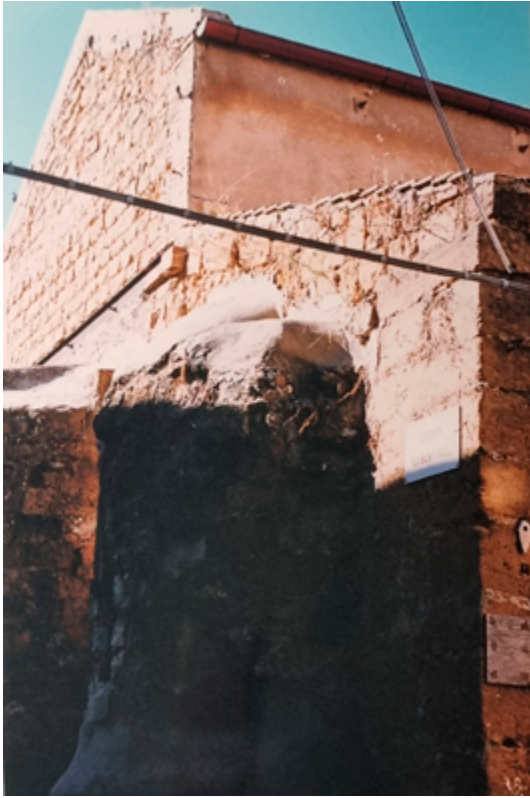
Fig. 101. Veduta lato est, zona absidale chiesa, dopo l'intervento di restauro del Valenti e alla vigilia dei restauri del 2002. Fonte: Archivio studio Sanzo Sajeve.
