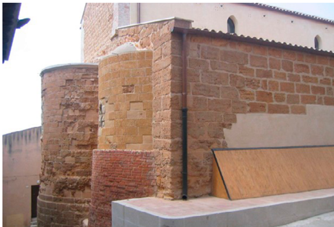
Fig. 23. Vista nord-orientale della chiesa Santa Maria dei Greci. Fonte: Autrice
