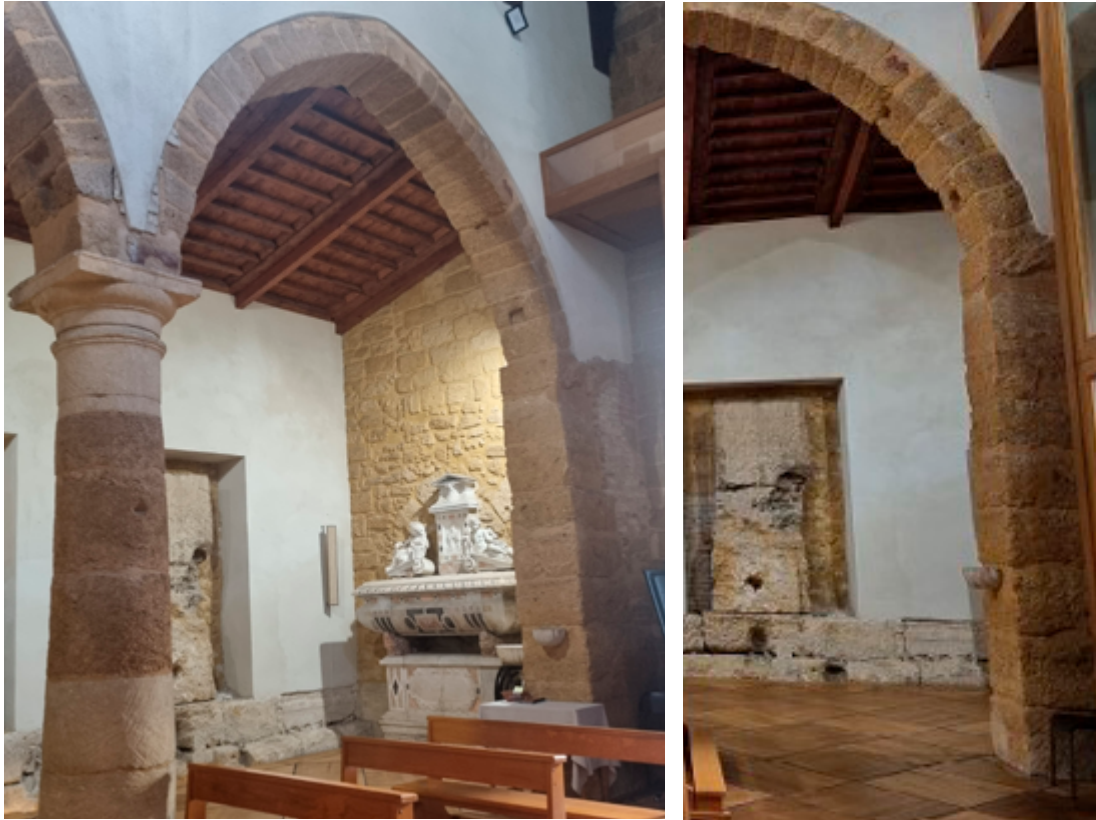
Figg. 45-46. Contrafforte ingresso chiesa. Fonte: Autrice.
