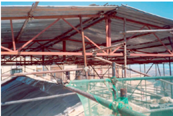
Fig. 225. Copertura navata centrale durante i lavori di sanificazione. Fonte: Ing. Giulio Sajevo.
