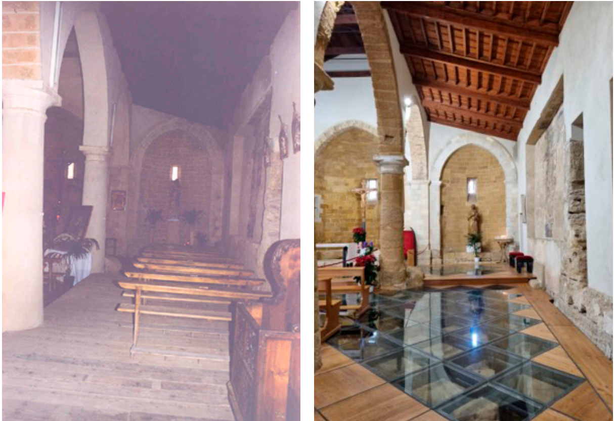
Figg. 210-211. Pavimentazione navata meridionale prima e dopo dell'intervento di restauro. Fonte: Autrice.
