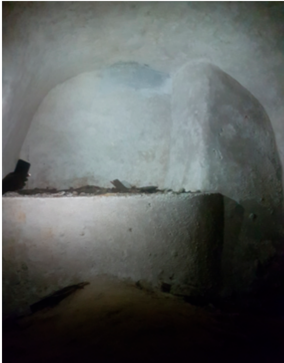
Fig. 137. Camera/ossario ai lati del corridoio, posto al di sotto della navata centrale della Chiesa San Domenico. Fonte: Autrice.
