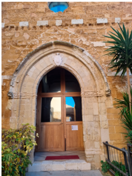
Fig. 11. Portale ingresso chiesa. Fonte: Autrice
