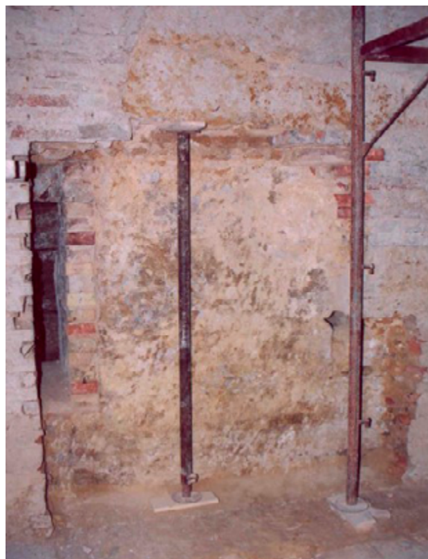
Figg. 195-196. Resti colonne peristasi nord tempio, prima dei lavori e dopo la rimozione dell'intonaco. Fonte: Ing. Giulio Sajeva.
