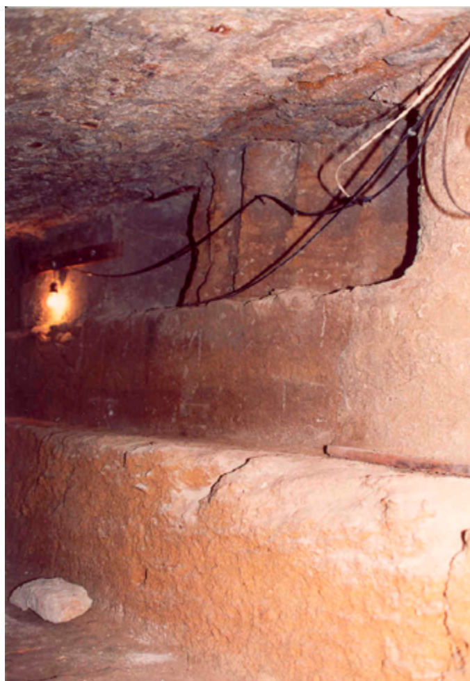
Fig. 175. Resto di colonna sottoposta alla spinta della volta della galleria. Fonte: Archivio studio Sanzo Sajeva.
