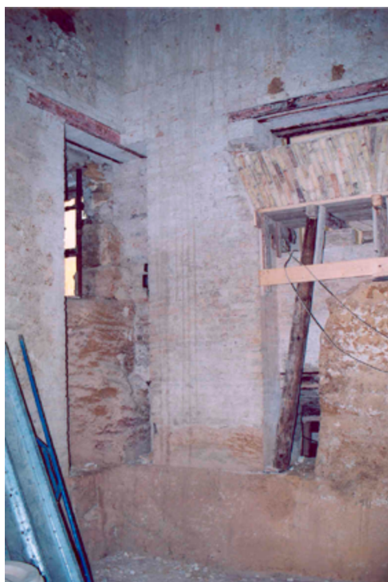
Fig. 201. Piattabanda ultimata. Fonte: Ing. Giulio Sajeve.
