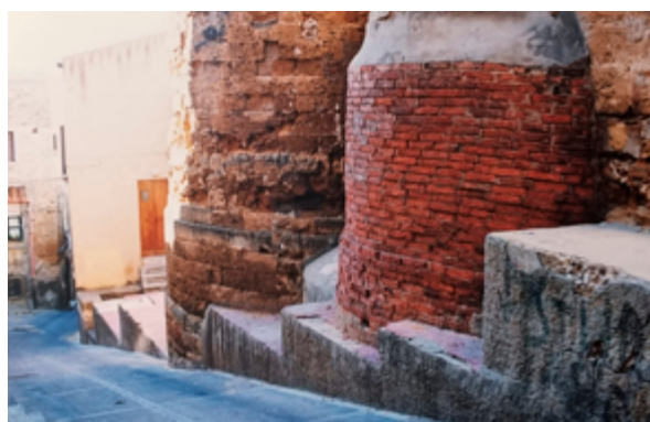
Fig. 100. Veduta lato est, zona absidale chiesa, dopo l'intervento di restauro del Valenti e alla vigilia dei restauri del 2002. Fonte: Archivio studio Sanzo-Sajeve.
