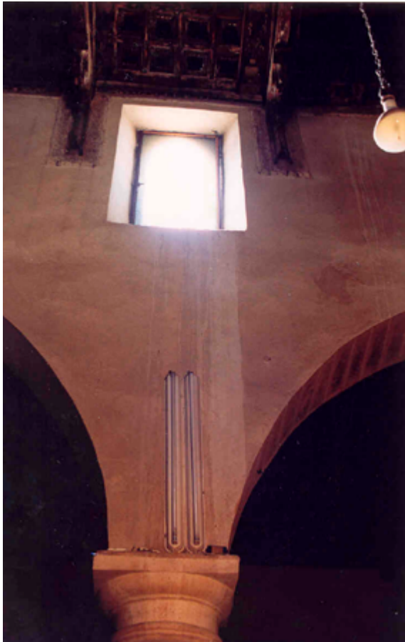
Fig. 202. Apertura navata centrale prima dell'inizio dei lavori. Fonte: Archivio studio Sanzo Sajeva.
