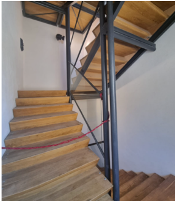
Fig. 157. Vista vano scala Antiquarium . Fonte: Autrice.
