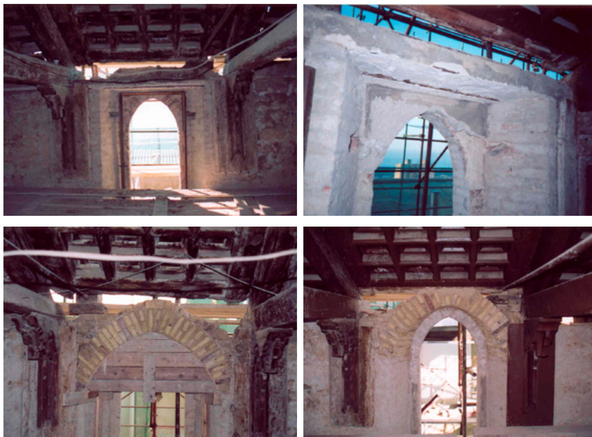
Figg. 203-204-205-206. Fase di intervento sulle aperture. Fonte: Archivio Studio Sanzo-Sajeva.
