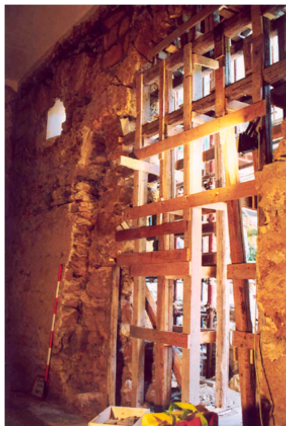
Figg. 163-164. Fasi lavorative di ricostruzione piedritto di sostegno archi Antiquarium . Autore: ing. Giulio Sajeva.
