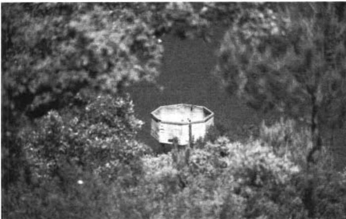
Figura 15. Estación inunda- da de El Gergal. Parte visible del depósito (km. 66)
