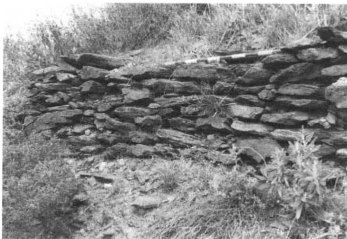
Figura 8. Detalle de la cerca en la ladera sur del cerro del Castillo.
