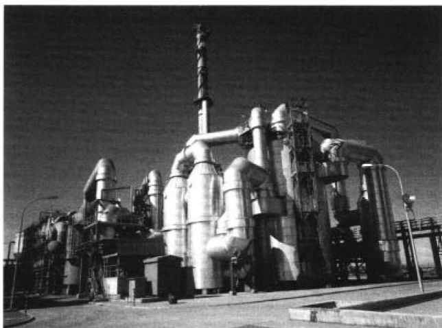
Figura 11. El complejo minero-metalúrgico Sotiel con- taba con una fábrica de ácido que empleaba pi- rita flotada. G. García, 1994.
