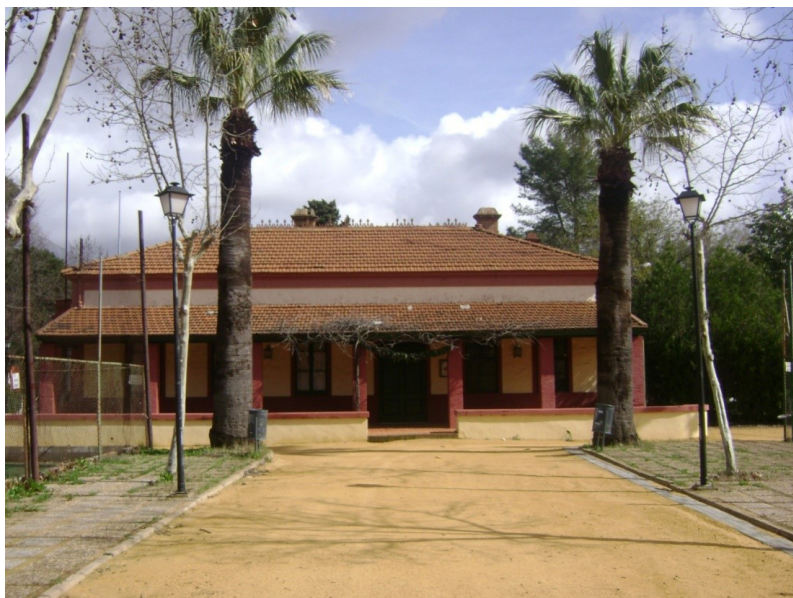
Fotografía 1: Actual edificio del English Club of Rio Tinto, hoy Club Inglés Bella Vista, en Minas de Riotinto (Huelva).
